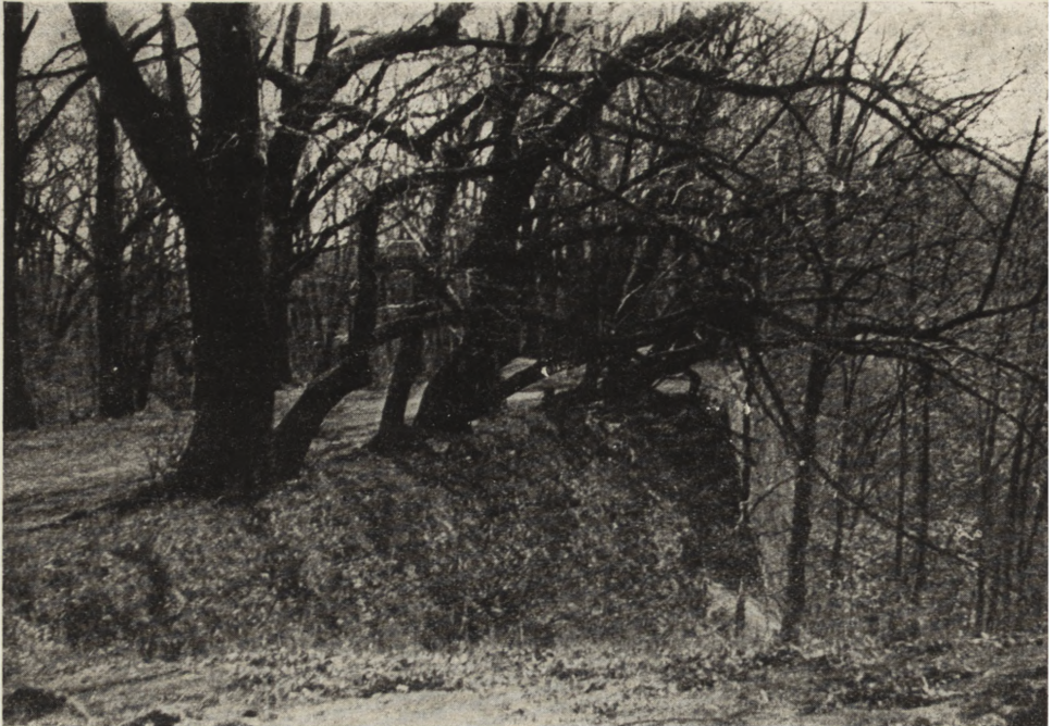
Ryc. 66. Zamek w Pilicy. Widok z platformy na kurtynę. Widoczna krawędź oskarpowania, bliżej uległo całkowitemu zniszczeniu. Drzewa wyznaczają wewnętrzną krawędź dawnego muru. 1959 r.
