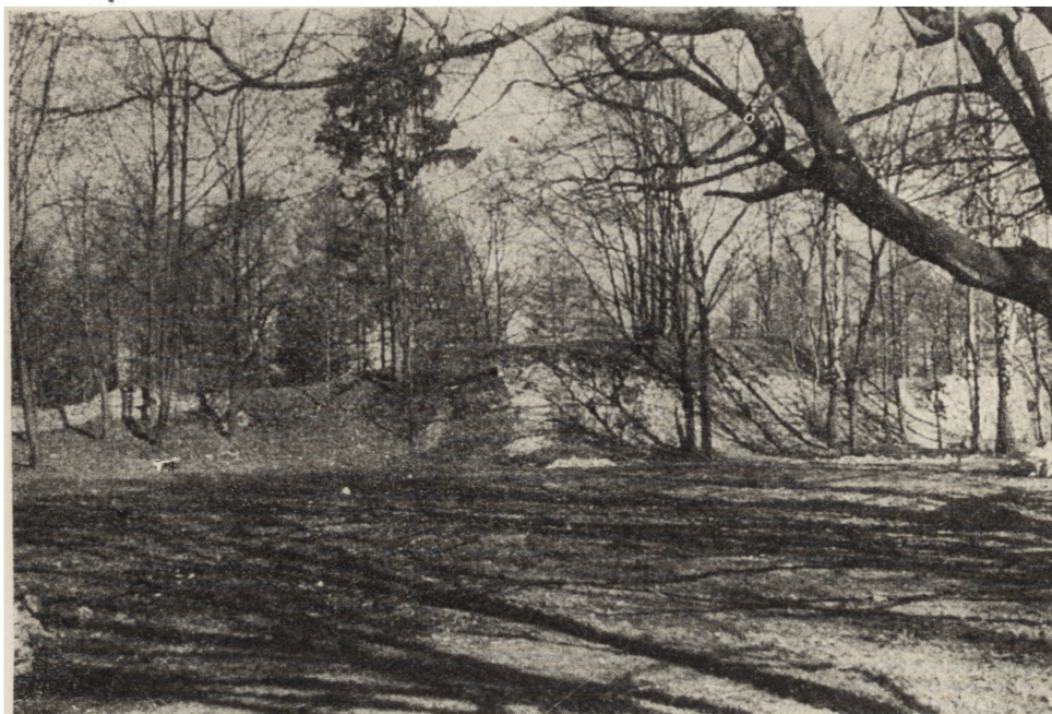
Rys. 65. Zamek w Pilicy. Widok platformy od strony fosy. Różny stopień zniszczenia muru oskarpowania: (od prawej) zachowane naroże muru, zniszczony sam mur, odsłonięte pionowe żebra wzmacniające, zniszczone żebra i rozmyty wał. 1959 r.
