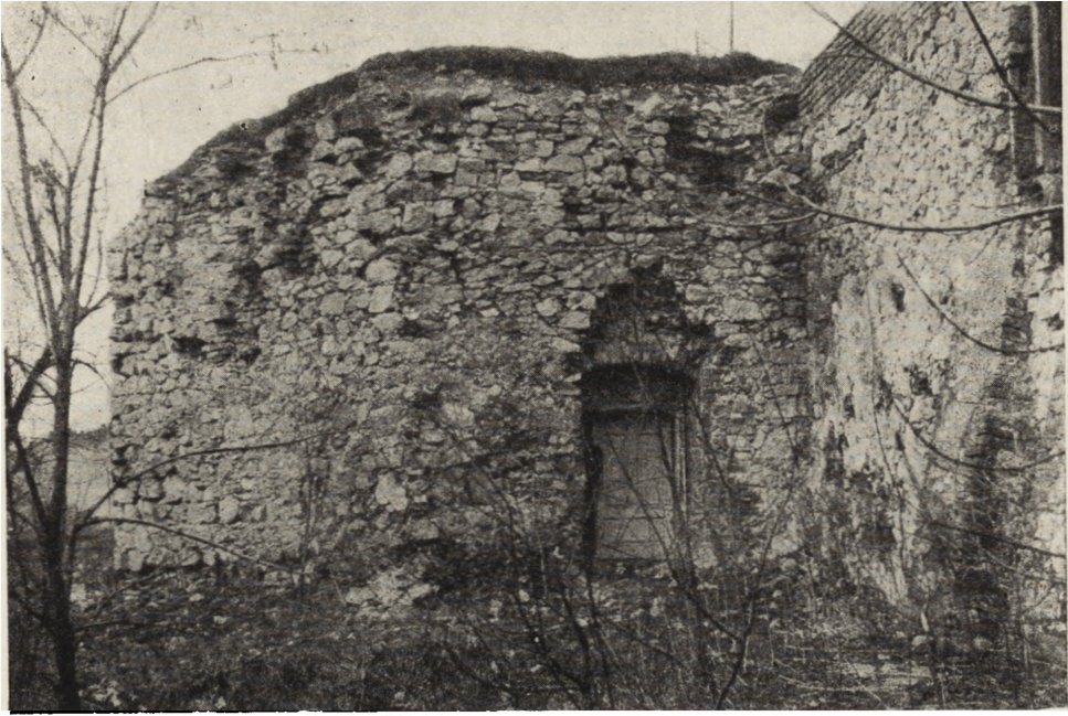
Ryc. 74. Baszta prochowa w Kielcach. Mur o rozluźnionym wiązaniu. Nieczytelny przebieg dalszych partii. 1959 r.
