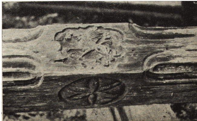
Ryc. 242. Byki — zamek. Renesansowa belka stropowa z herbem Stanisława Bykowskiego.
