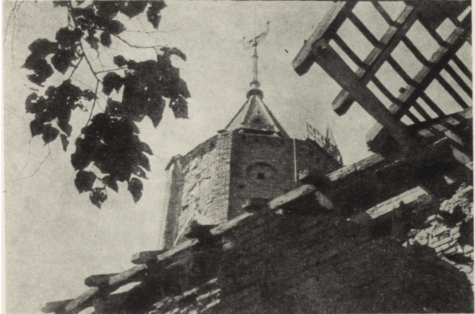
Ryc. 6. Opinogóra, zameczek, widok korony murów elewacji wschodniej i zwieńczenia wieży. (Fot. inż. S. Karpieł)
