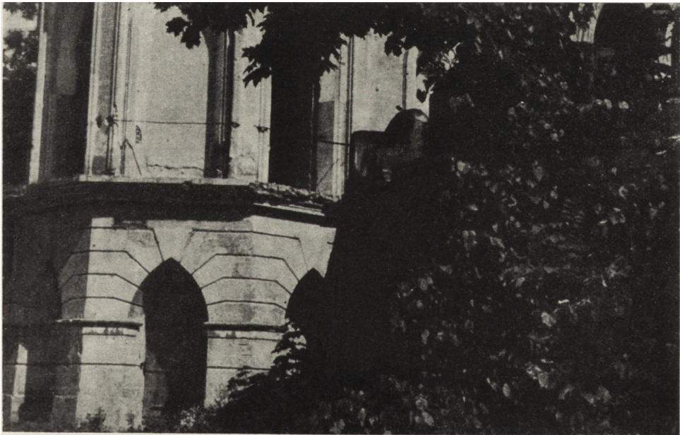
Ryc. 3. Opinogóra, zameczek, widok cokołu i dolnej części pierwszej kondygnacji wieży od strony południowej. (Fot. inż. S. Karpiel)
