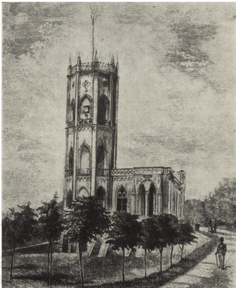
Ryc. 1. Opinogóra, zameczek, 2. ćwierćwiecze XIX w., widok od strony południowo-wschodniej wg ilustracji w „Tygodniku Ilustrowanym” II, 1877, s. 336. (Fot. Pracownia Konserwacji Zabytków)
