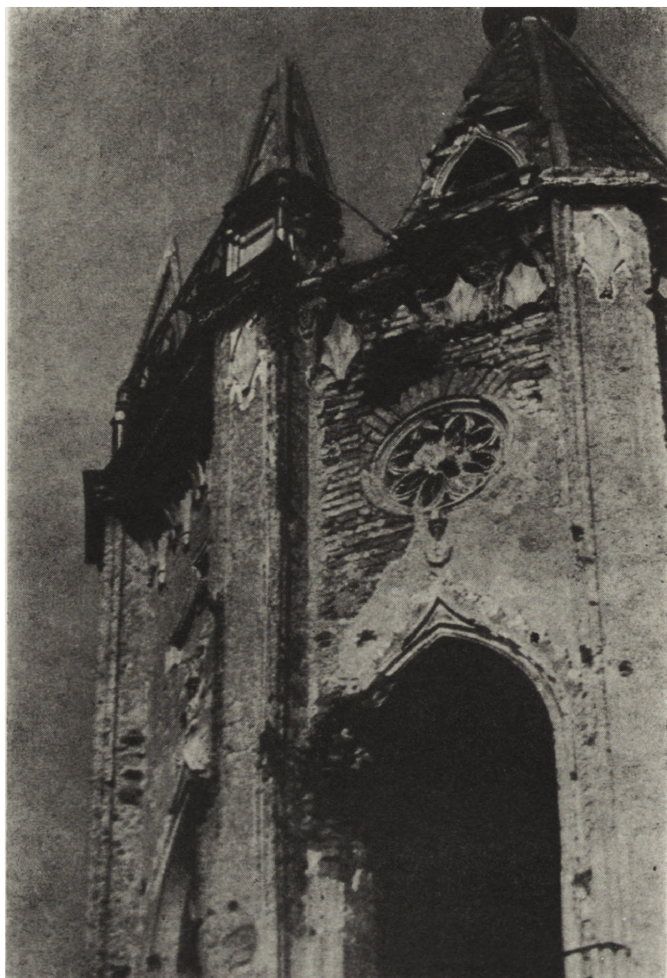
Ryc. 8. Opinogóra, zameczek, górna kondygnacja wieży. (Fot. inż. S. Karpiel)
