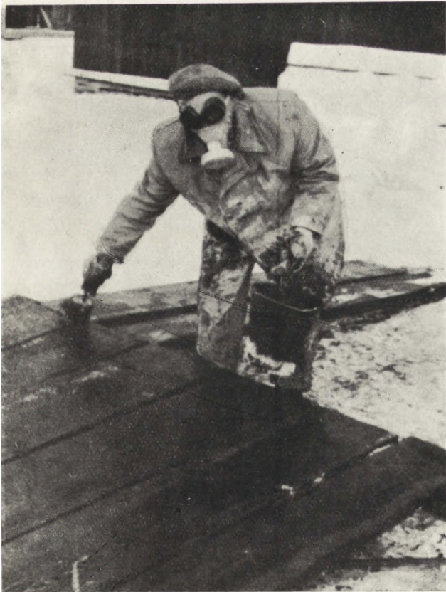
Ryc. 15. Kościół w Dębnie, odgrzybianie desek podłogowych. (fot. M. Walther)
