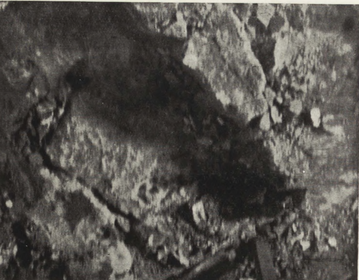
Ryc. 6. Kościół w Dębnie, zniszczenie drewna w narożniku ścian, wywołane grzybem Lenzites sepiaria . (fot. W. Galewski)
