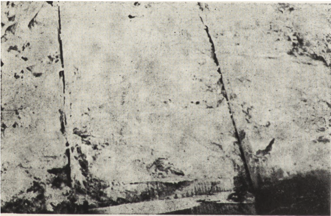
Ryc. 1. Kościół w Dębnie, zagrzybione deski podłogowe. (fot. E. Stawinoga i M. Walther)
