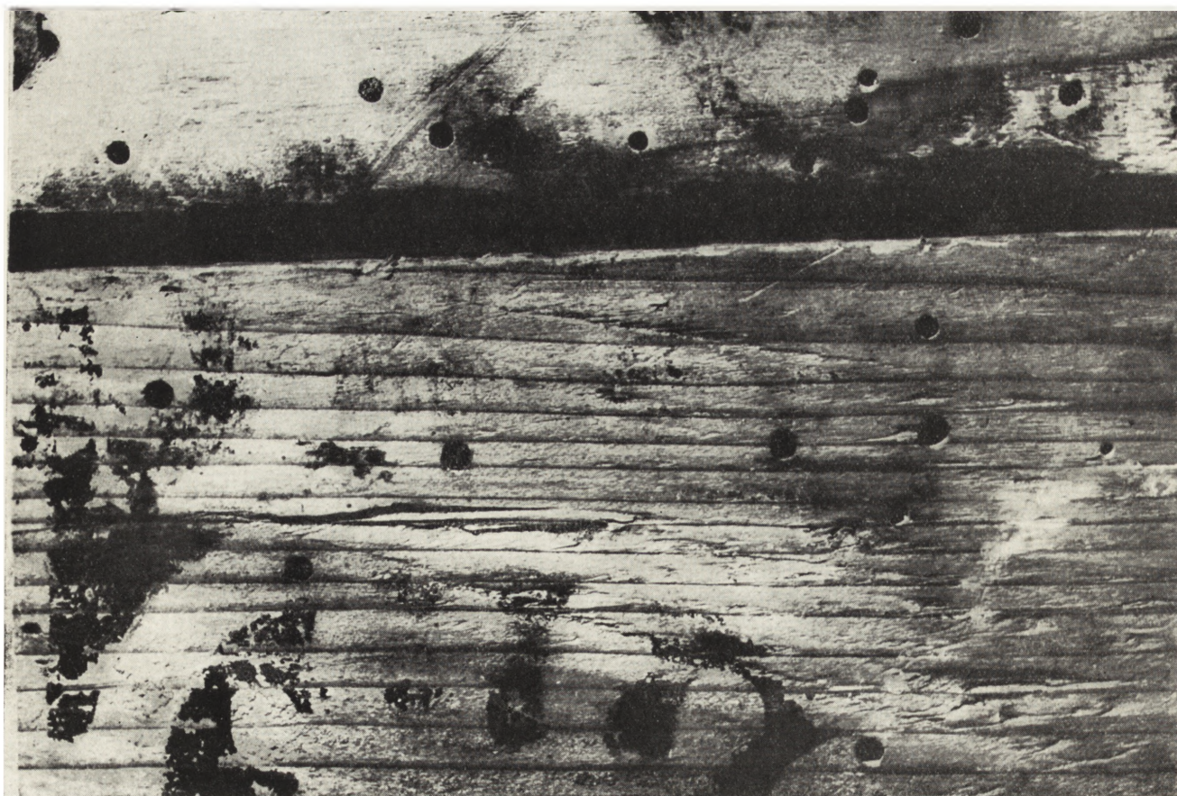
Ryc. 16. Dębno, kościół, nawa, zaskrzynienie północne — otwory wylotowe drewnojadów (makrofotografia; fot. J. Wróblewski)
