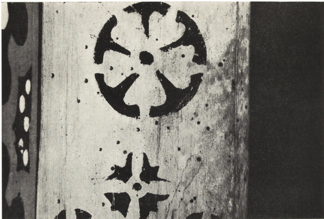
Ryc. 15. Dębno, kościół, nawa, ściana wschodnia -- otwory wylotowe drewnojadów (makrofotografia; fot. J. Wróblewski)
