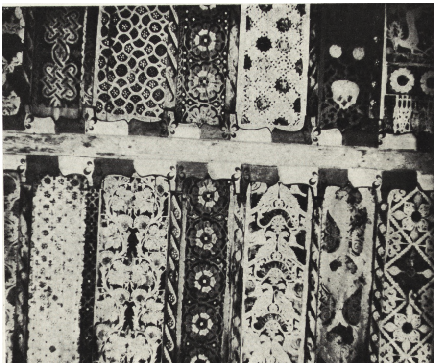
Ryc. 4. Dębno, kościół, nawa, fragment polichromii stropu (fot. W. Werner)
