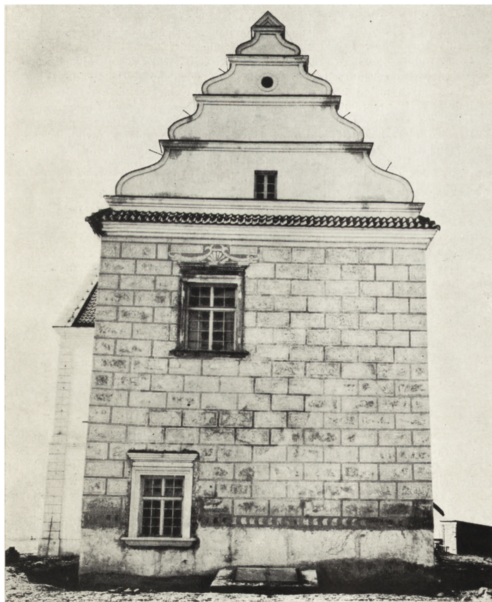
Ryc. 2. Działoszyn, zameczek, elewacja północna po odbudowie (fot. W. Tomicka)
