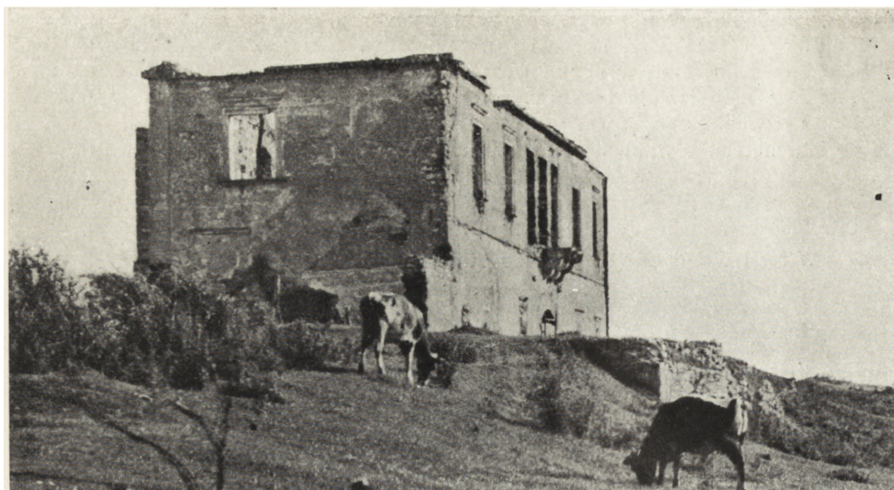
Ryc. 1. Działoszyn, zameczek, elewacja północna i zachodnia przed odbudową (fot. W. Tomicka)
