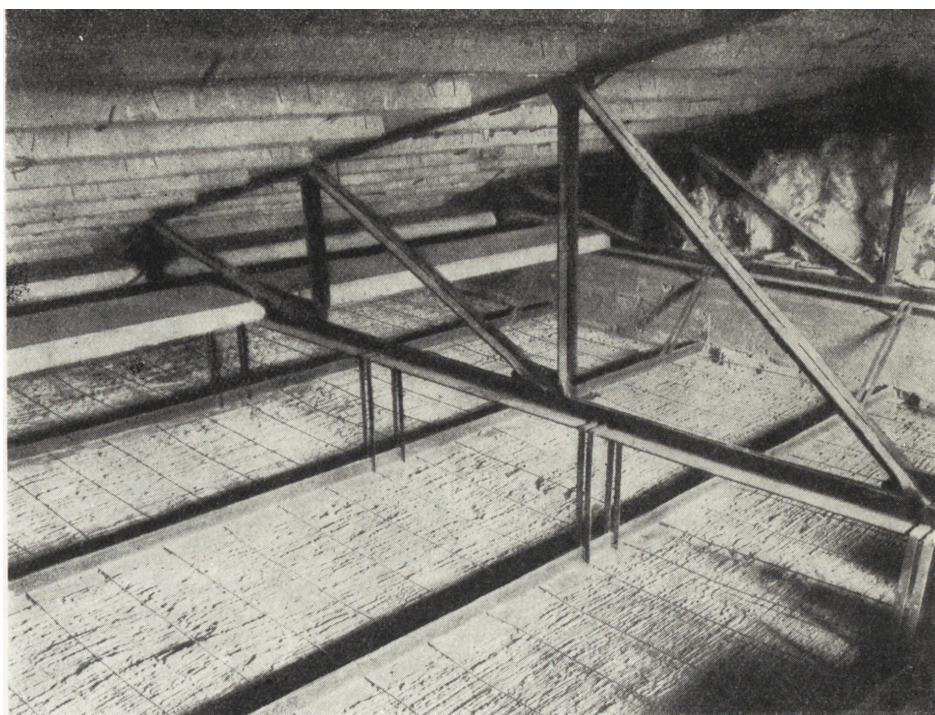
Ryc. 9. Skrzydło południowe, podwieszanie plafonu do wiązarów stalowej konstrukcji dachowej (fot. Pracownia Konserwacji Zabytków)
