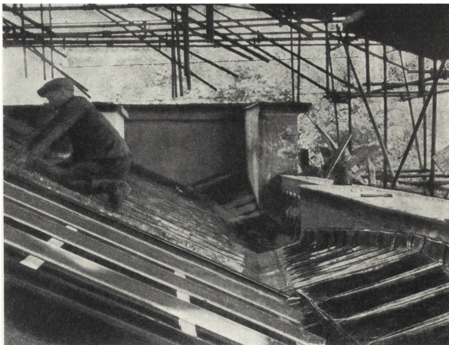
Ryc. 10. Skrzydło południowe, krycie dachu blachą miedzianą na nowej konstrukcji (fot. Pracownia Konserwacji Zabytków)
