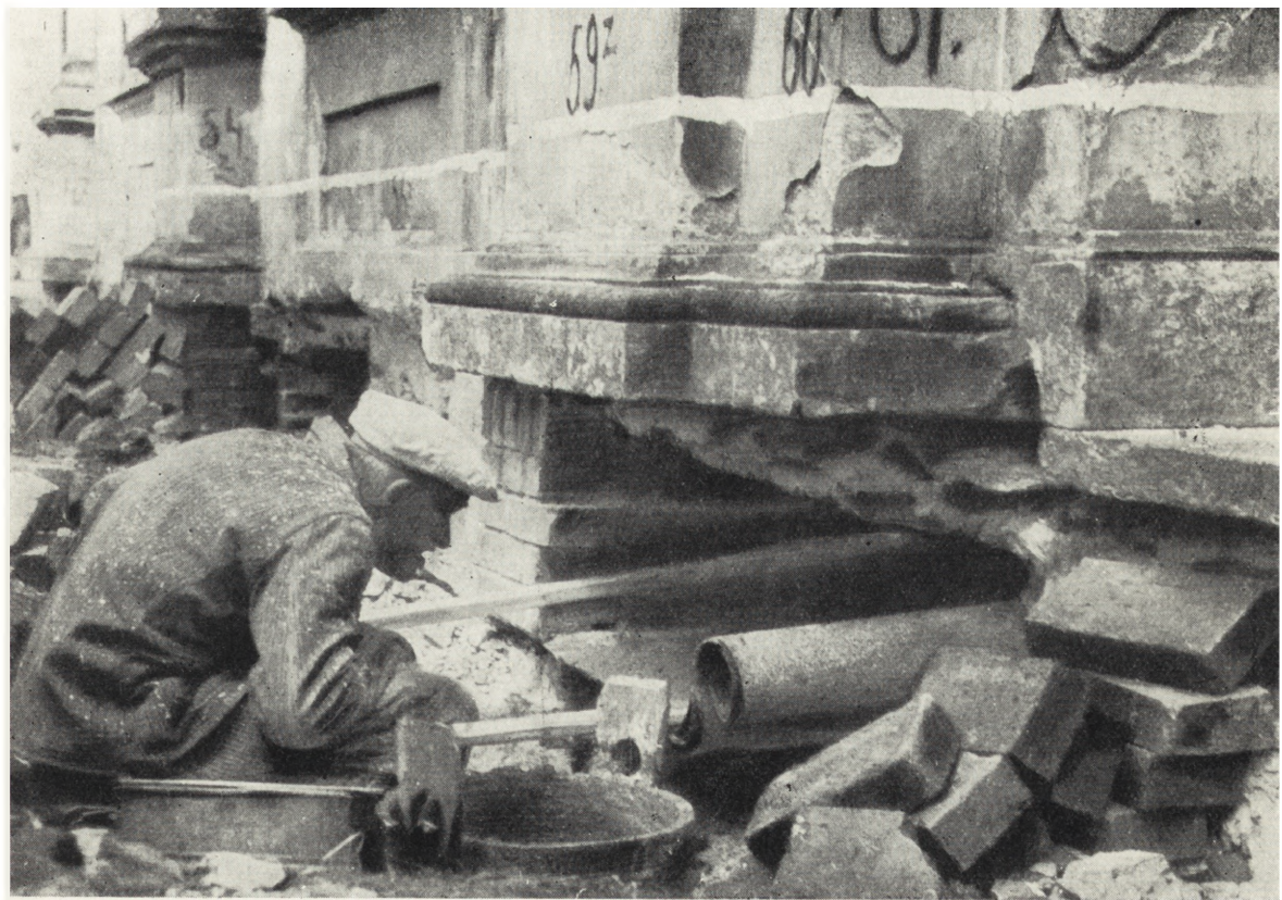
Ryc. 4. Skrzydło południowe, zakładanie izolacji poziomej (fot. Pracowni Konserwacji Zabytków)
