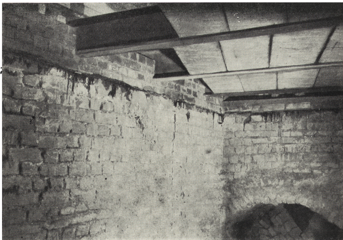
Ryc. 2. Galeria północna, fragment stropu z ułożonymi płytami prefabrykowanymi nad piwnicami (fot. Pracownia Konserwacji Zabytków)
