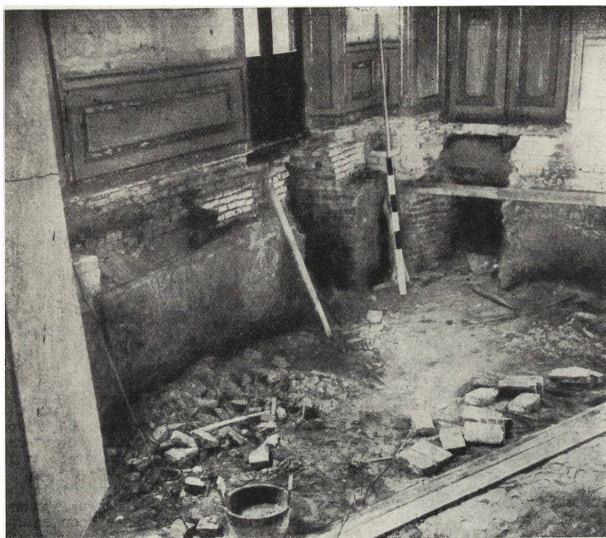
Ryc. 1. Korpus główny, pogłębianie piwnic pod Antykamerą Króla (fot. Pracownia Konserwacji Zabytków)
