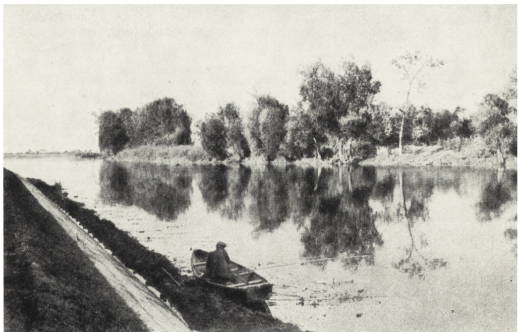
Ryc. 11. Prace regulacyjne wybrzeża
