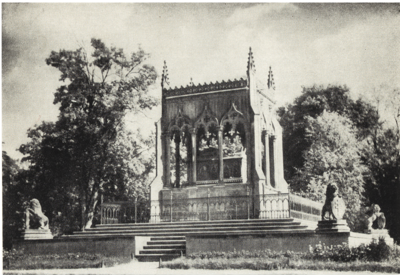
Ryc. 16. Mauzoleum Potockich po rekonstrukcji
