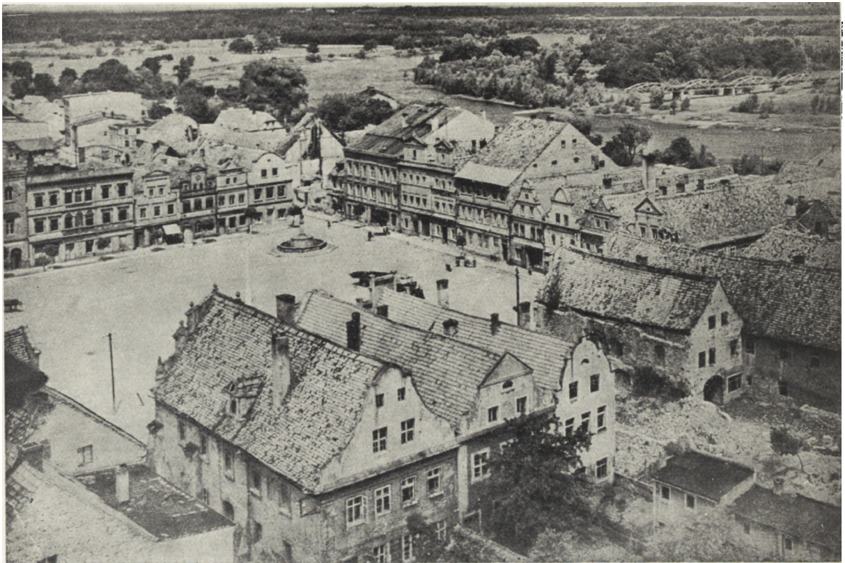
Ryc. 12. Bytom Odrzański, ogólny widok Rynku przed przystąpieniem do prac konserwatorskich. Pierwszy z prawej — budynek hotelu pod Złotym Lwem (fot. J. Szandomirski)
