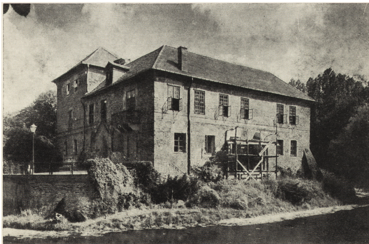
Ryc. 7. Oporów, zameczek, elewacja południowa w trakcie odmurowywania profilu gotyckich okien (fot. PKZ — K. Kowalska)
