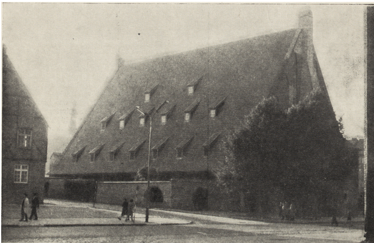
Ryc. 4. Gdańsk, Wielki Młyn, stan po odbudowie. Widok od strony płd.-wschodniej (fot. M. Paździor)
