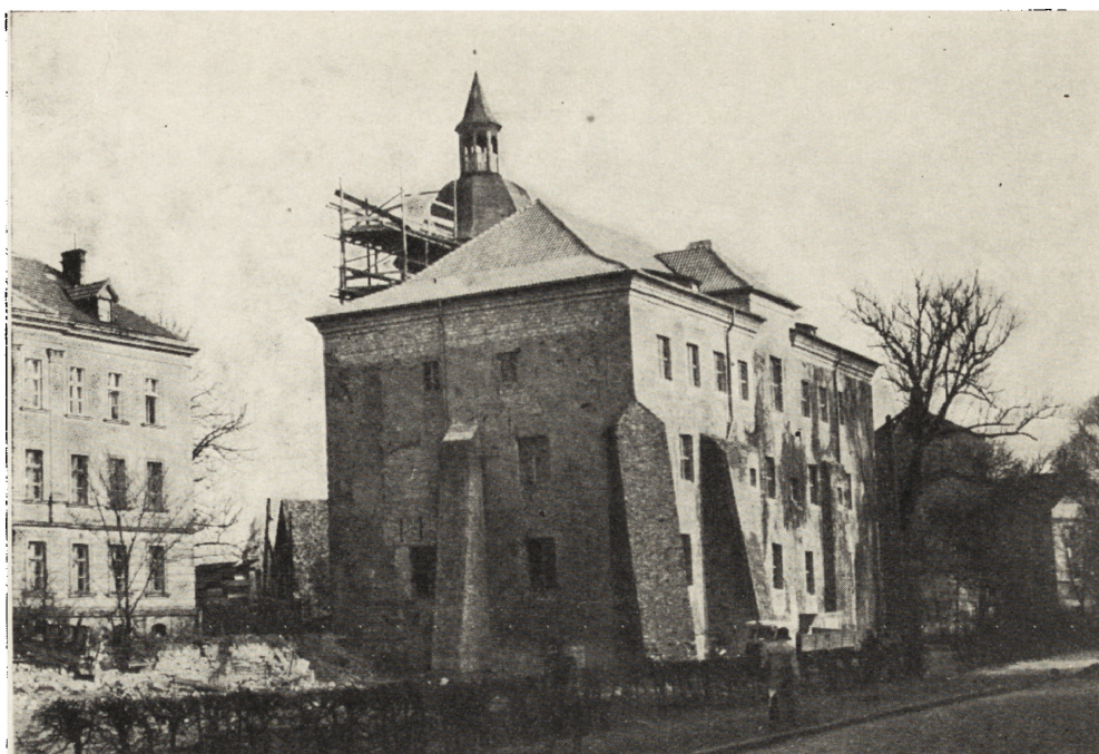
Ryc. 6. Słupsk, zamek, widok podczas odbudowy (fot. F. Ptaszyński)
