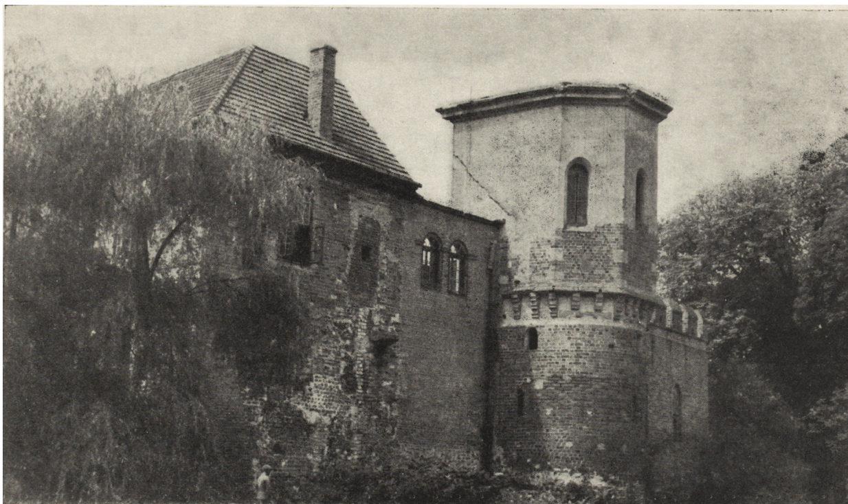
Ryc. 8. Oporów, zameczek, elewacja wschodnia po częściowym zniesieniu XIX-wiecznej dobudówki pomiędzy budynkiem mieszkalnym i kaplicą i w czasie wymiany dachu nad kaplicą (fot. PKZ — K. Kowalska)
