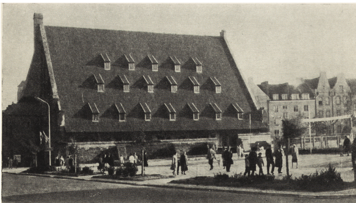
Ryc. 5. Gdańsk, Wielki Młyn, stan po odbudowie. Widok od strony płn.-zachodniej (fot. M. Paździor)
