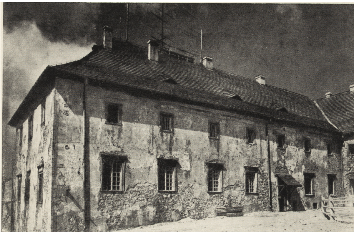
Ryc. 10. Święty Krzyż, zachodnia część klasztoru w trakcie prac konserwatorskich (fot. PKZ — K. Kowalska)
