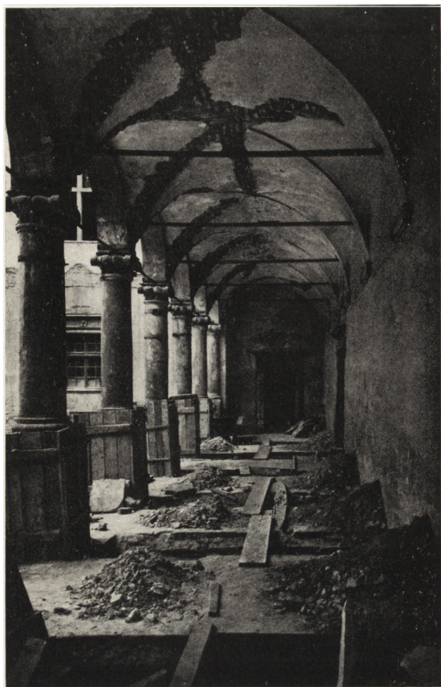
Ryc. 10. Baranów, zamek, zabezpieczanie krużganków renesansowych (fot. E. Rachwał)
