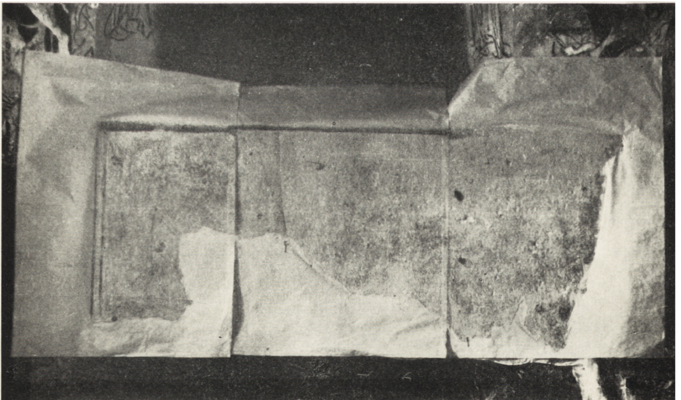
Ryc. 2. Brzeg, kościół p. w. św. Mikołaja, zakrystia. Fragment malowidła „Msza św. Grzegorza” w czasie zabezpieczenia lica przed przenoszeniem. (Fot. W. Wagner)
