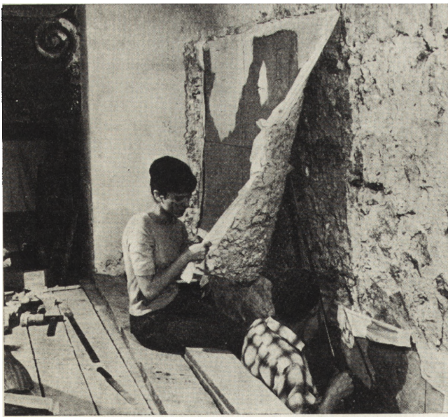
16. Ściana północna. Przenoszenie malowidła z XIV w. — odspajanie płata od wątku (fot. Wacław Wagner)
