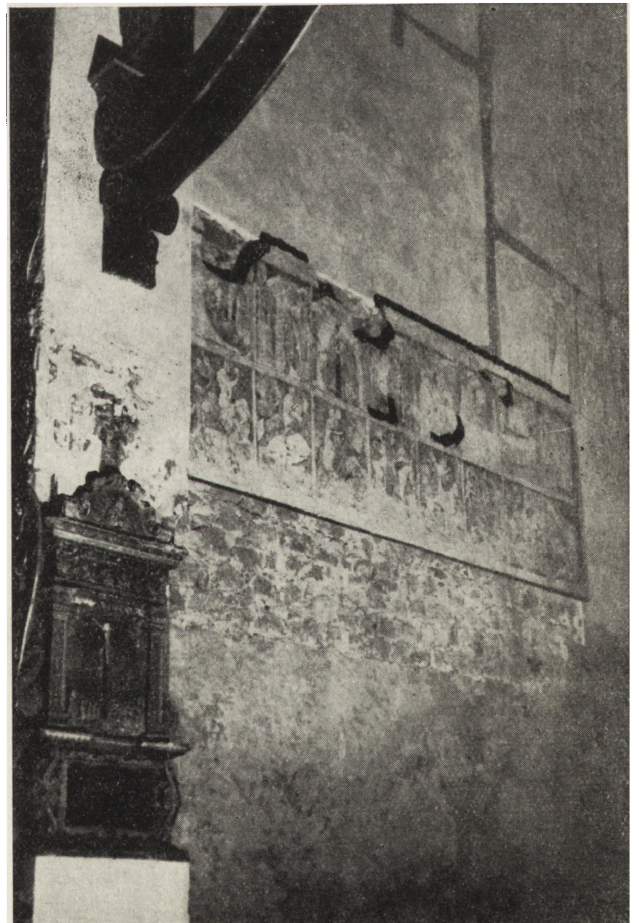
26. Ściana północna. Transfer na nowym podłożu z płyty pilśniowej, osadzony z powrotem na ścianie prezbiterium (fot. Marian Kornecki)
