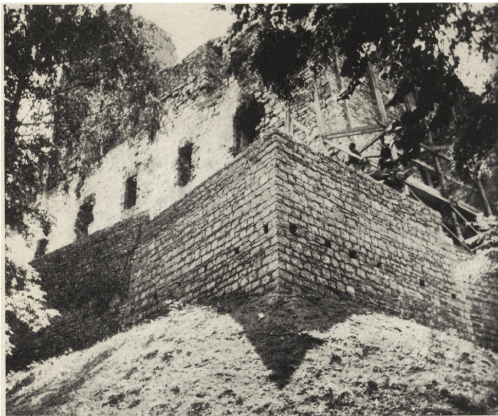
26. Lipowiec, pow. Chrzanów, częściowa rekonstrukcja bastionu przez integrację zharmonizowaną z całością zamku (fot. J. Bogdanowski)
