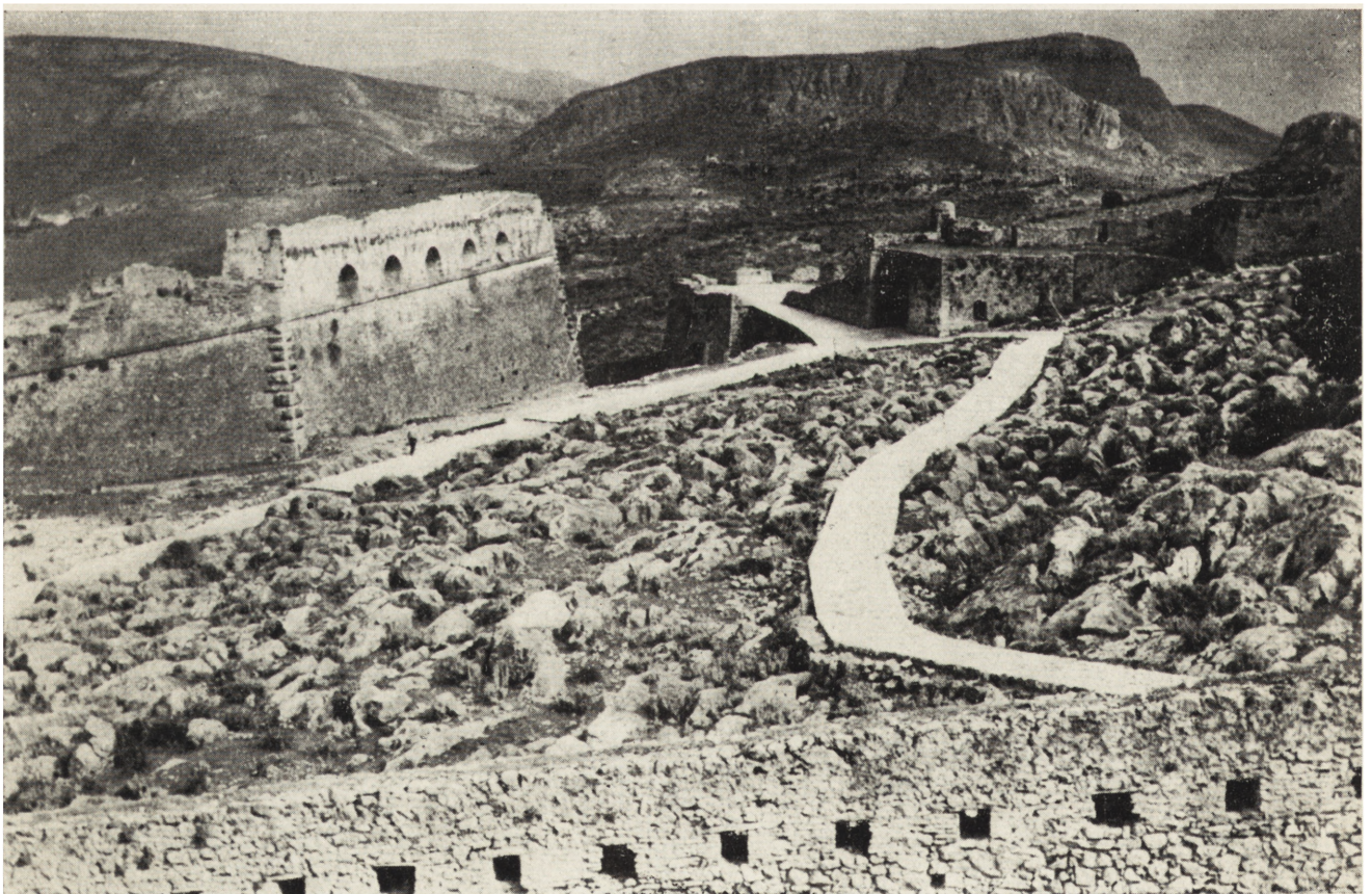
30. Nauphia, zamek, przykład restauracji i adaptacji do celów turystycznych; w rekonstruowanym murze na pierwszym planie na uwagę zasługuje opracowanie korony nie „zlicowanej” od góry lecz zachowującej właściwy przekrój ze zróżnicowaniem licówki i wnętrza muru, rażąco natomiast potraktowane urządzenia adaptacyjne: ścieżki, rampy i schody (fot. J. Bogdanowski)
