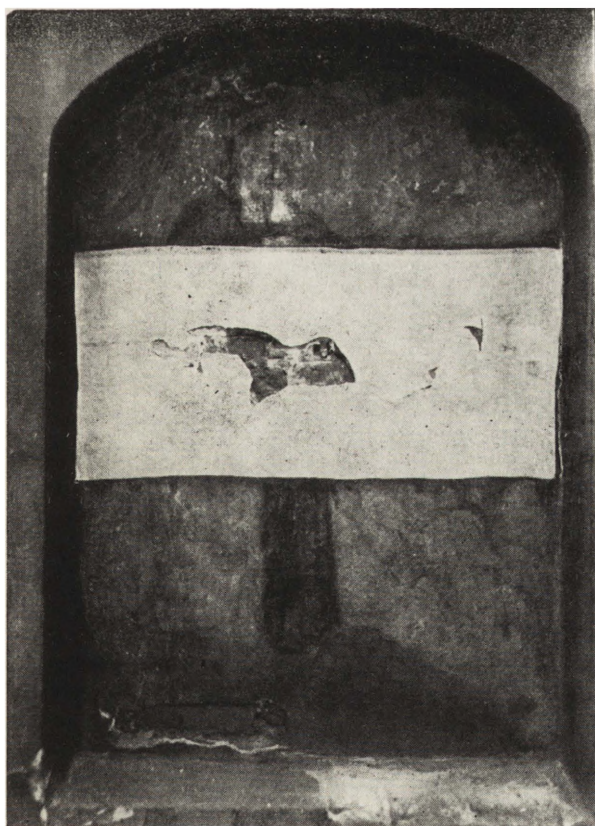
1. Kraków. Kanonicza 23, malowidło przedstawiające św. Iwonę. Stan podczas oczyszczania; widoczne zabezpieczenie środkowej partii obrazu batystem
