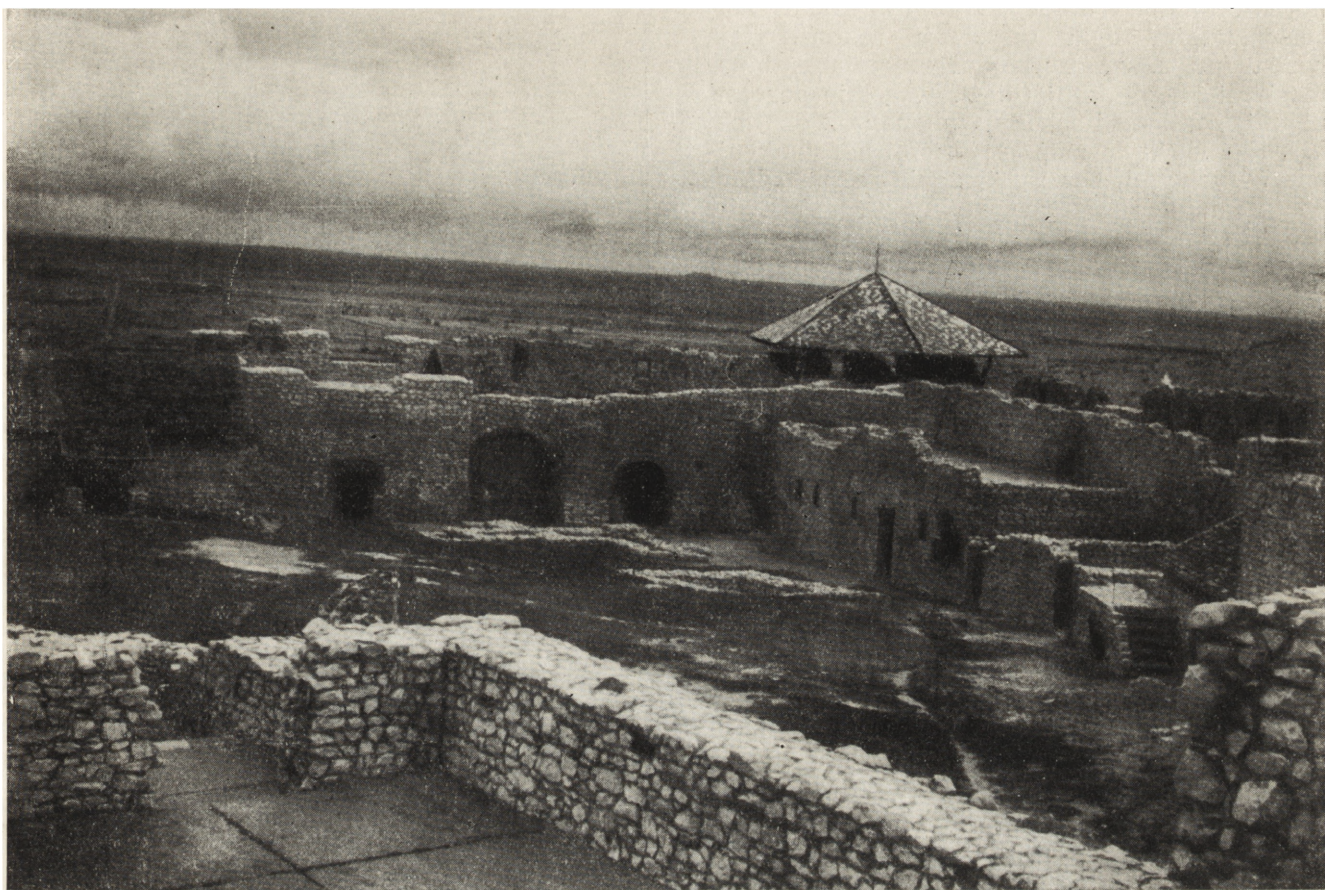
9. Sümegeg. Zamek, widok na dziedziniec wewnętrzny po konserwacji 9. Sümegeg. Château, vue sur la cour intérieure après les travaux de conservation
