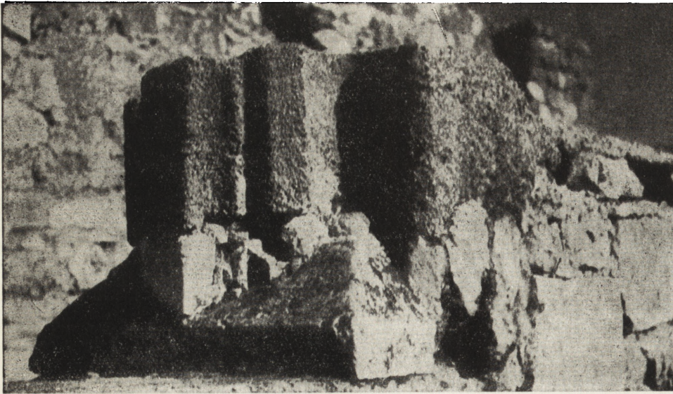
7. Zsambek. Klasztor z XII—XIII w., fragment uzupełnionego nowym materiałem, profilowanego detalu kruzganka
