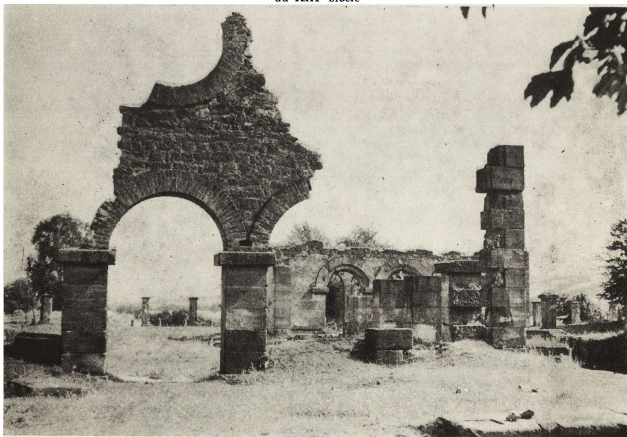
3. Ruiny walcowni z I połowy XIX w. w Nietulisku (woj. kieleckie). Świadczą one nie tylko o architekturze dawniej istniejących budynków fabrycznych lecz również o procesie technologicznym, który się w nich odbywał (Fot. A. Funkiewicz)
