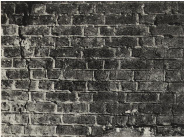
4. Wrocław. Kościół klarysek (obecnie urszulanek). Fragment ceglano-licca ścian wnętrza ze spoinami pomalowanymi paskiem białej farby (fot. autor)
