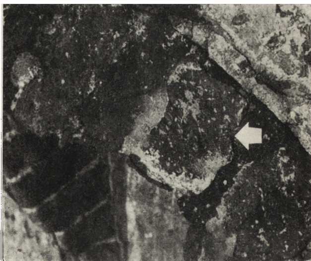
12. Wrocław. Klasztor bernardynów. Fragment żebra w skrzydle północnym krużganka. Cegły krzesane pokryte cienkim tynkiem pomalowanym żółtą farbą (fot. autor)
