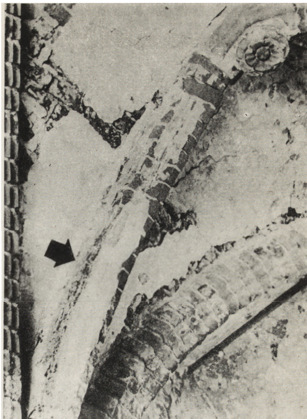
11 Wrocław. Klasztor bernardynów. Fragment żeber w południowym skrzydle krużganka, pokrytych cienkim tynkiem-pobiałą i malowanych czerwoną farbą (fot. autor)
