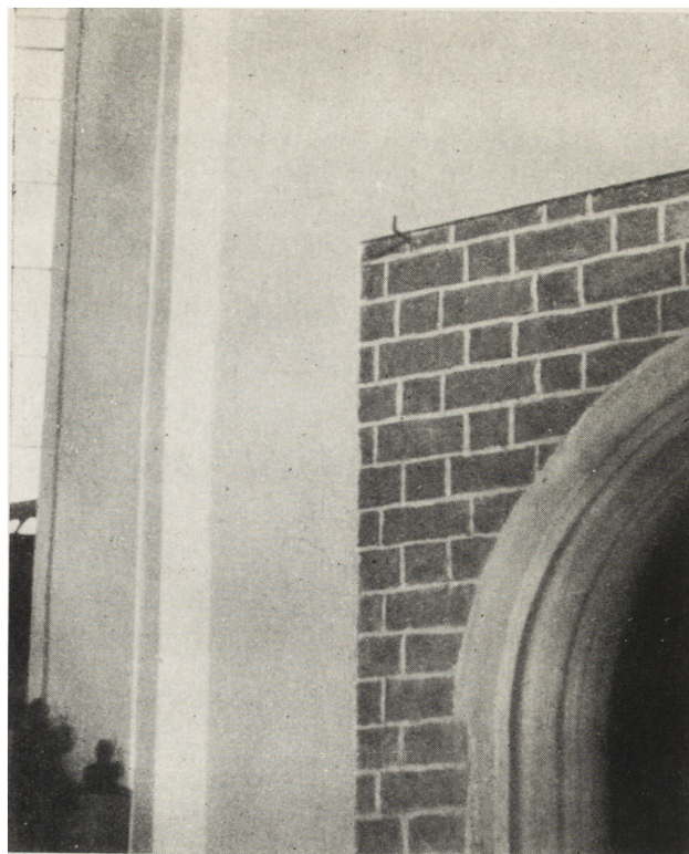
24. Wrocław. Kościół św. Krzyża. Fragment ściany nawy południowej z lizeną narożną transeptu i portalem. Części narożne lizeny kryją pod cieńszym tynkiem ceglane, malowane krawędzie (fot. autor)
