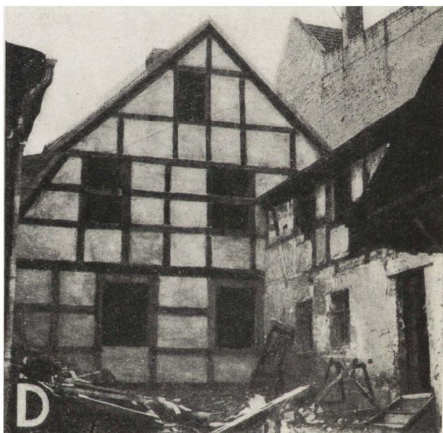
9. Elewacja tylna. Etapy prac konserwatorskich. A — rozbiórka do budowy ceglanej i uzupełnienie ściany parteru nowym murem, maj—czerwiec 1964 oraz usunięcie wypełnień w partii szczytowej, listopad 1964, B — odsłonięcie śladów pierwotnej konstrukcji parteru, zachowanych w belce oczepowej przyziemia. Podjęcie decyzji o restytucji dawnego wyglądu tej części elewacji, listopad 1964, C — rozbiórka murów ceglanych parteru, wymiana podwaliny, maj 1965, D — stan surowy po częściowej wymianie elementów drewnianych i założeniu wypełnień, czerwiec 1965 (fot. P. Gartkiewicz; B. Kosacki — A)
