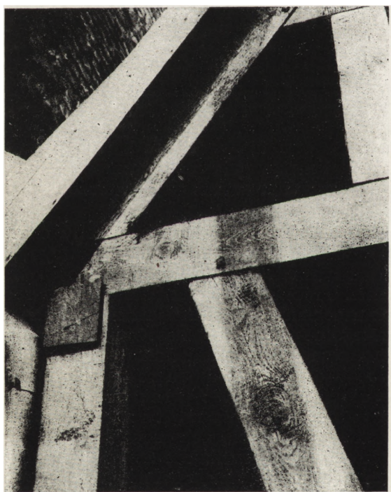
17. Przykłady wymiany i rekonstrukcji brakujących elementów szkieletu drewnianego. Elewacja frontowa. A — narożnik zachodni. Stan przed przystąpieniem do robót i po przeprowadzeniu wymiany elementów z przywróceniem ich pierwotnej formy (czoło oczepu ściany zachodniej), B — narożnik wschodni, widok z ulicy i od wnętrza budynku. Stan przed (widoczne ubytki, przesunięcia i zrabanie słupów) i po dokonaniu uzupełnień i wymiany. (fot. P. Gartkiewicz)
