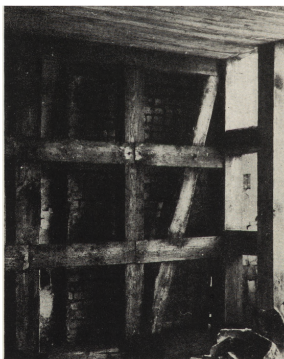
17. Przykłady wymiany i rekonstrukcji brakujących elementów szkieletu drewnianego. Elewacja frontowa. A — narożnik zachodni. Stan przed przystąpieniem do robót i po przeprowadzeniu wymiany elementów z przywróceniem ich pierwotnej formy (czoło oczepu ściany zachodniej), B — narożnik wschodni, widok z ulicy i od wnętrza budynku. Stan przed (widoczne ubytki, przesunięcia i zrabanie słupów) i po dokonaniu uzupełnień i wymiany. (fot. P. Gartkiewicz)
