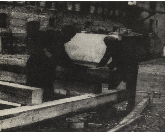
15. Prace ciesielskie. Wymiana całkowicie zniszczonych elementów elewacji frontowej. A — wstępne przycinanie słupów piłą, B — końcowa obróbka toporem, C — dopasowywanie nowych elementów do reliktów pierwotnej konstrukcji złożonych ponownie na dziedzińcu posesji (fot. P. Gartkiewicz)
