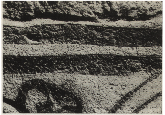
3. Rytowana posadzka romańska. Wycinek fragmentu oczyszczonego mechanicznie
