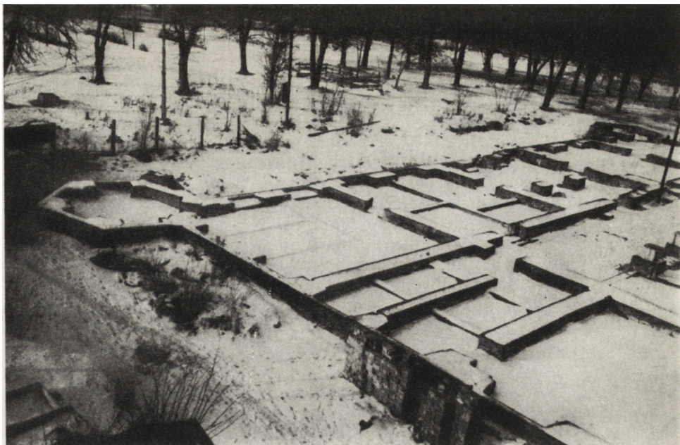
19. Warszawa. Pałac Ujazdowski. Widok ogólny ruiny podczas prac konserwatorskich, stan z 1966 r. (fot. A. Gruszecki)
