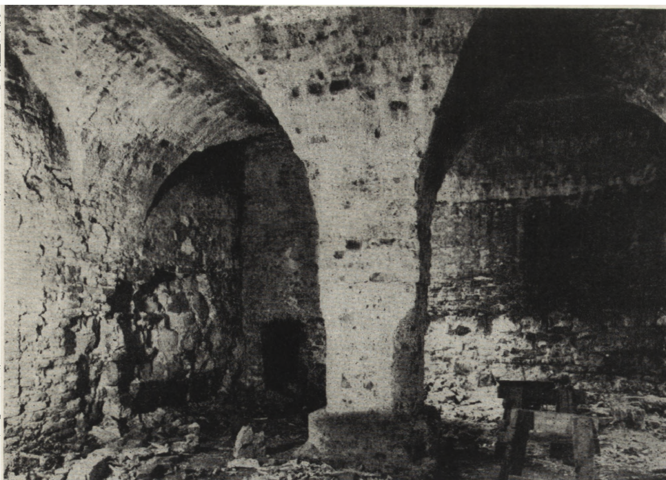
10. Warszawa. Pałac Ujazdowski. Piwnice XVII-wieczne, stan przed przystąpieniem do ostatnich prac konserwatorskich
