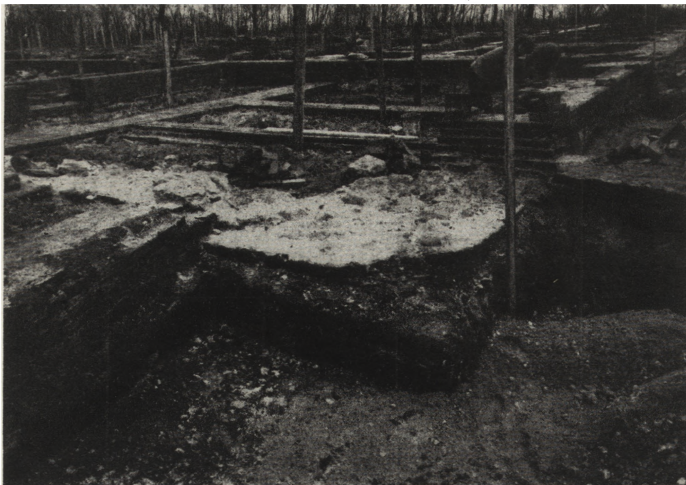
17. Warszawa. Pałac Ujazdowski. Prace przy rekonstrukcji krony murów (fot. A. Gruszecki)
