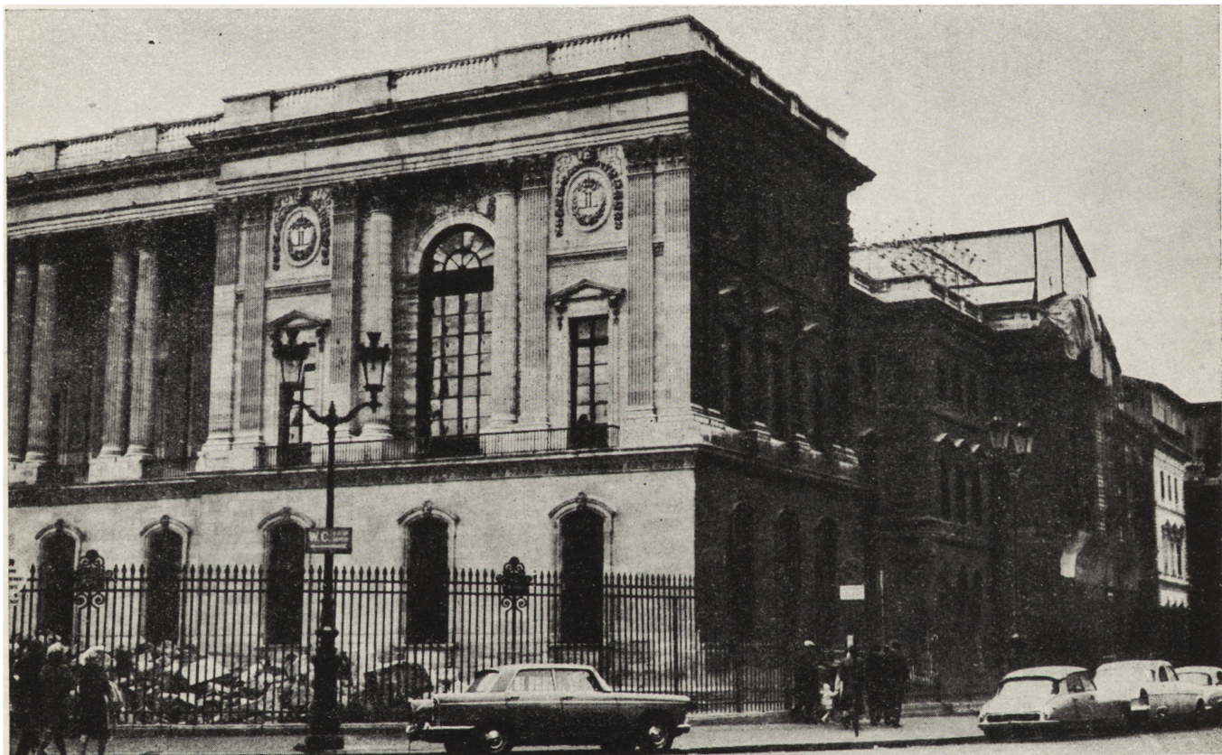
2. Paryż. Luwr. Narożnik przy Rue de Rivoli — Rue du Louvre. Stan w toku prac oczyszczających, 1964 r.
