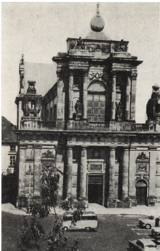
11. Warszawa. Fasada kościoła pokarmelickiego przy ul. Krakowskie Przedmieście. Widoczne, narastające z wysokością zanieczyszczenie detali architektonicznych i wystroju rzeźbiarskiego, 1966 r.
