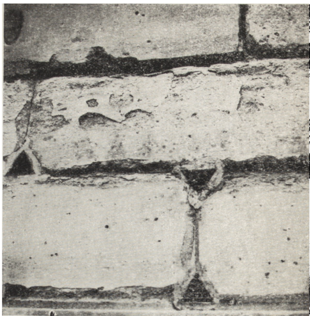
9. Paryż. Panteon. przyziemie fasady od strony Place du Panthéon osuszane rurkami systemu Knapena, 1964 r.
