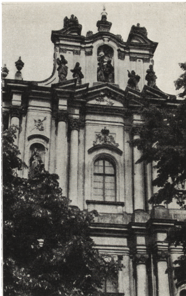
12. Warszawa. Fragment fasady kościoła Wizytek. Widoczne zanieczyszczenie i szernienie wystroju rzeźbiarskiego w górnych partiach, 1966 r.
