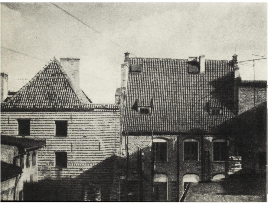
10. Toruń, elewacja podwórzowa budynków przy ul. Szczytnej 11 i 13 odsonięta podczas sanacji bloku (fot. J. Gardzielewska)
