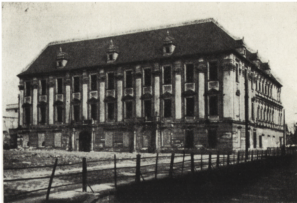
1. Nysa. Palais Episcopal, façade occidentale et fragment du canal, état en 1961
