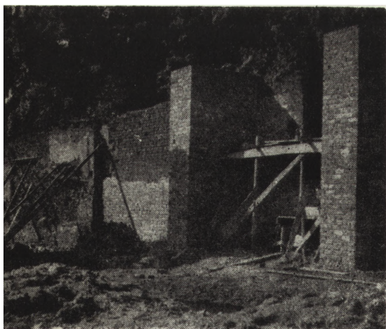
3. Koszalin, fragment murów miejskich, stan w trakcie robót konserwatorskich — 1960 r. (fot. F. Ptaszyński)
