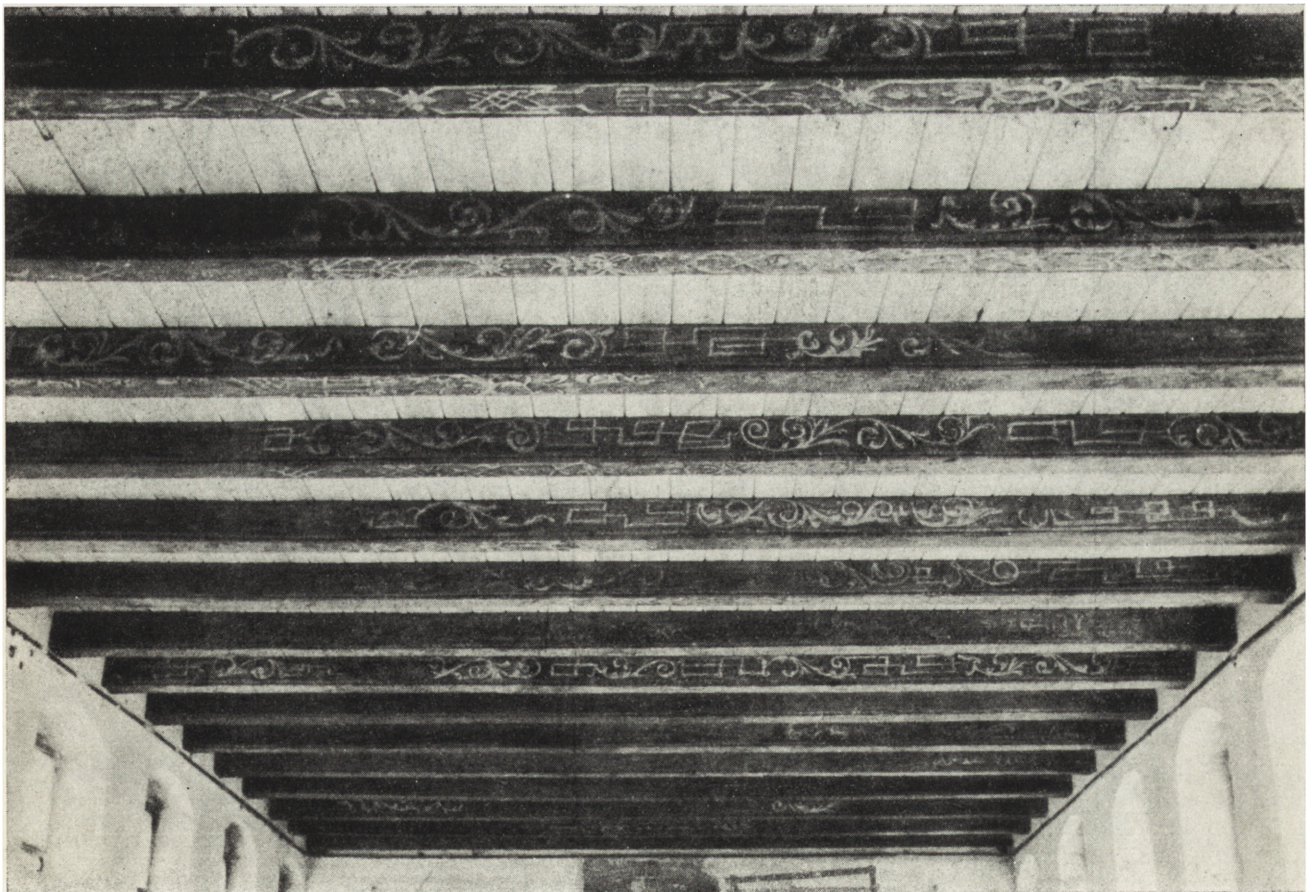
2. Toruń, Hôtel de Ville, plafond dans la Salle bourgeoise, état après la conservation
