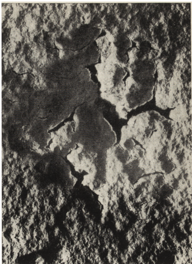
7. Złuszczenie się powłoki mydła cynkowego wskutek działania krystalizujących się soli (fot. B. Olechnicki)
