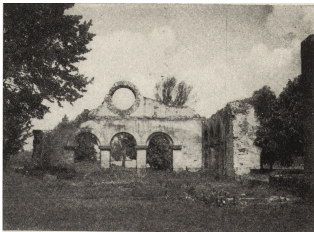
1. Nietulisko Fabryczne, pow. Opatów, dawne zakłady przemysłowe, stan w 1964 r. (fot. T. Siudowski)
