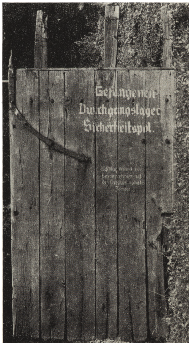
3. Zamość, Rotunda, skrzydło drewnianych wrót z niemieckim napisem, stan przed konserwacją (fot. W. Kurpik)
