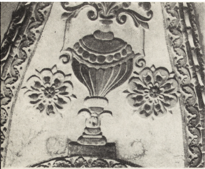
3. Zamość, dawna bóżnica, dekoracja naroża z widocznymi fragmentami oryginalnej polichromii odsłoniętymi spod tynku
