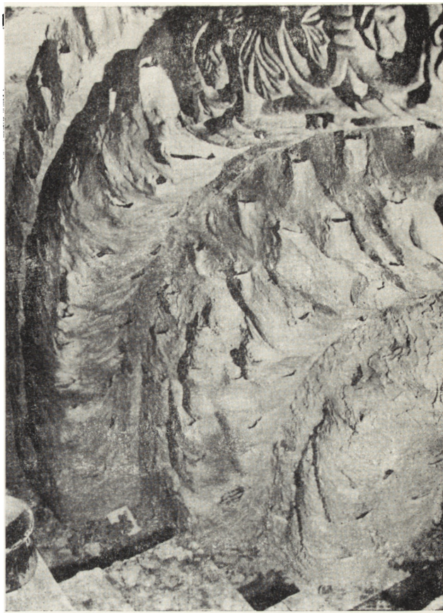
8 a, b. Portal z Ołbina, detale z założonymi kieszeniami, a — archiwolta b — kolumny
