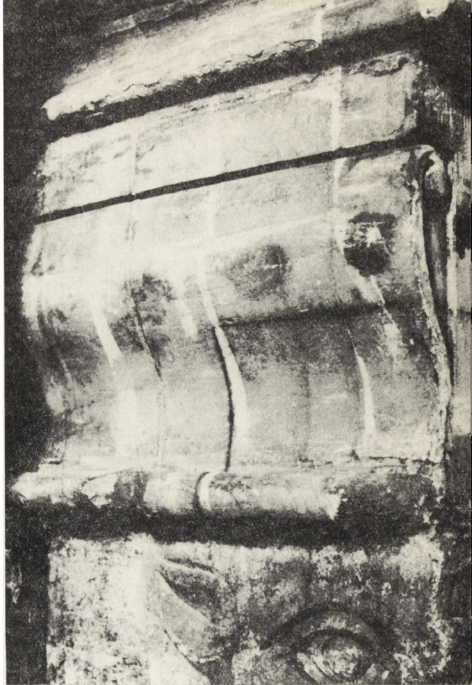
11. Portal z Ołbina, ślady gipsu po usunięciu kieszeni
