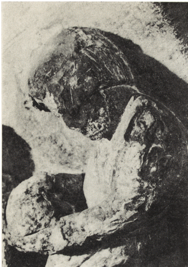
5. Portal z Olbina, fragment archiwolty po usunięciu powłoki organicznej z widocznymi kitami cementowymi
