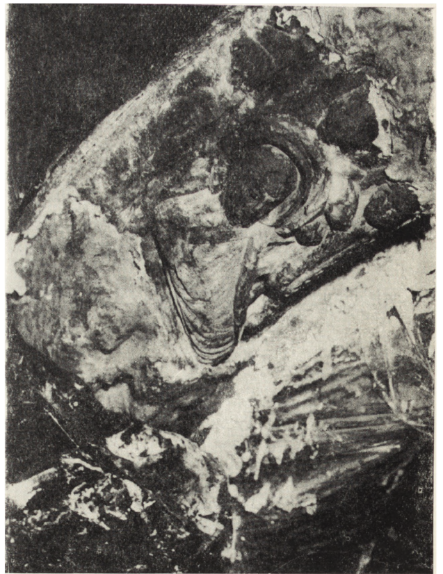
10 a, b. Portal z Olbina, usuwanie kieszeni po nasyceniu kamienia
