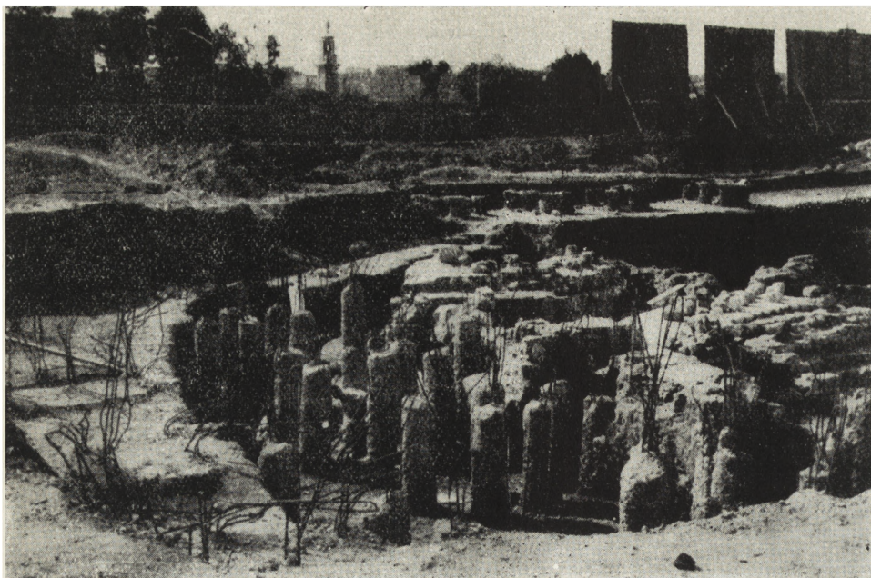
13. Aleksandria, teatr, żelbetowe pale fundamentowe przed usunięciem (fot. W. Kołtąj)
