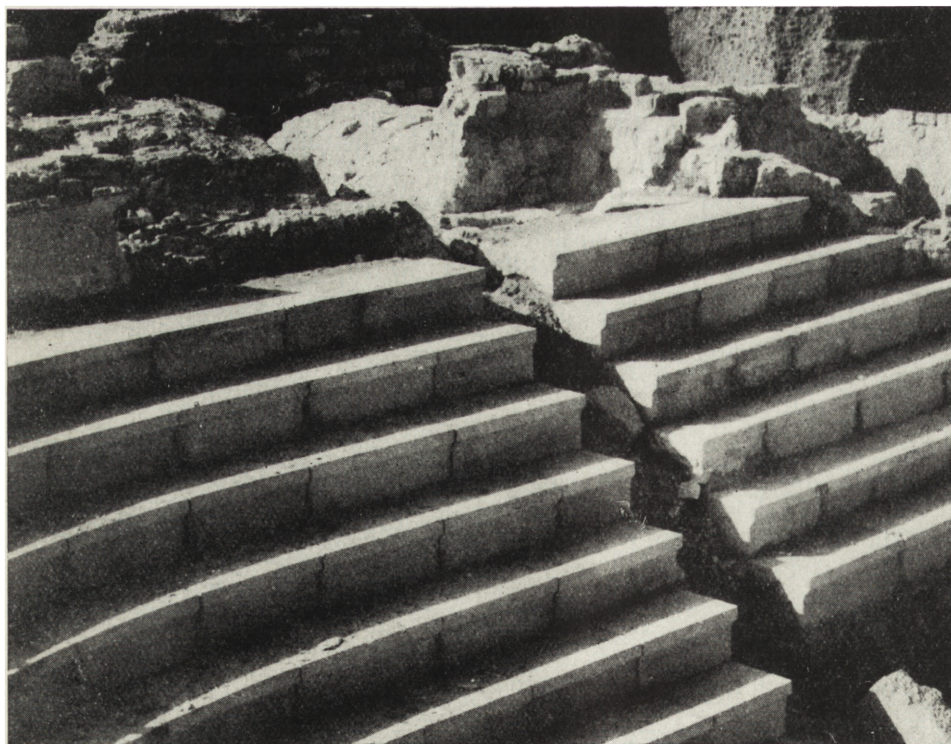
8. Aleksandria, teatr, południowa część widowni w trakcie rekonstrukcji, widoczny łuk parodos oraz negatywy brakujących dwu najwyższych rzędów siedzeń (fot. W. Kołataj)
