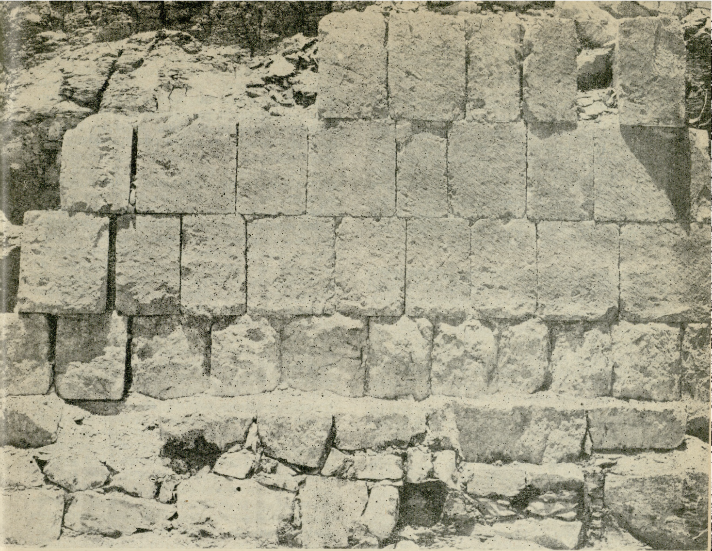
6. Deir el Bahari, świątynia królowej Hatszepsut, południowy fragment ściany wieńczącej — widoczny sposób dopasowania kamieni i obróbka lica (fot. W. Jerke)
