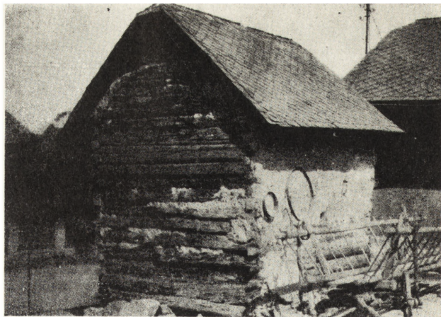
3. Borucin pow. Racibórz, spichlerz o kopulasto sklepionym zrębie i dachu luźno nałożonym (fot. A. Kuczyński)
