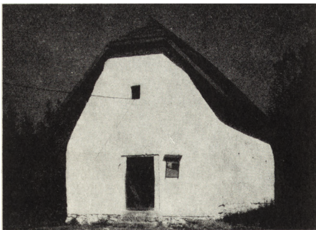
2. Głogówek pow. Prudnik, spichlerz o kopulasto sklepionym zrębie i dachu luźno nałożonym. Obiekt obecnie znajduje się na terenie Muzeum Wsi Opolskiej (fot. J. Michałowski)
