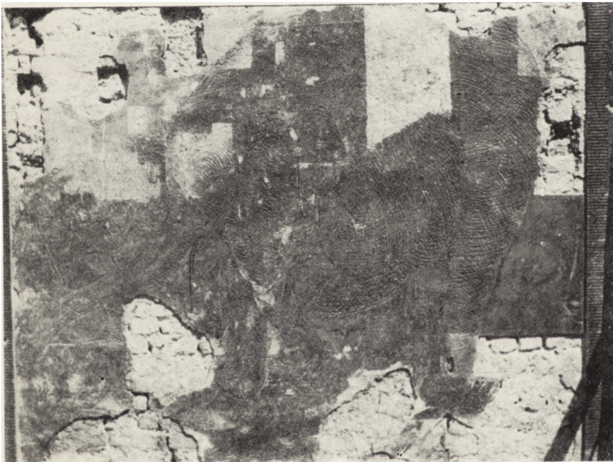
8. Trzebiatów, ul. Zajazdowa, sgraffito, stan po usunięciu starych kitów i częściowym zdjęciu warstw przemalowań; z prawej strony nie usunięty fragment z r. 1895 z drzewkiem i datą
