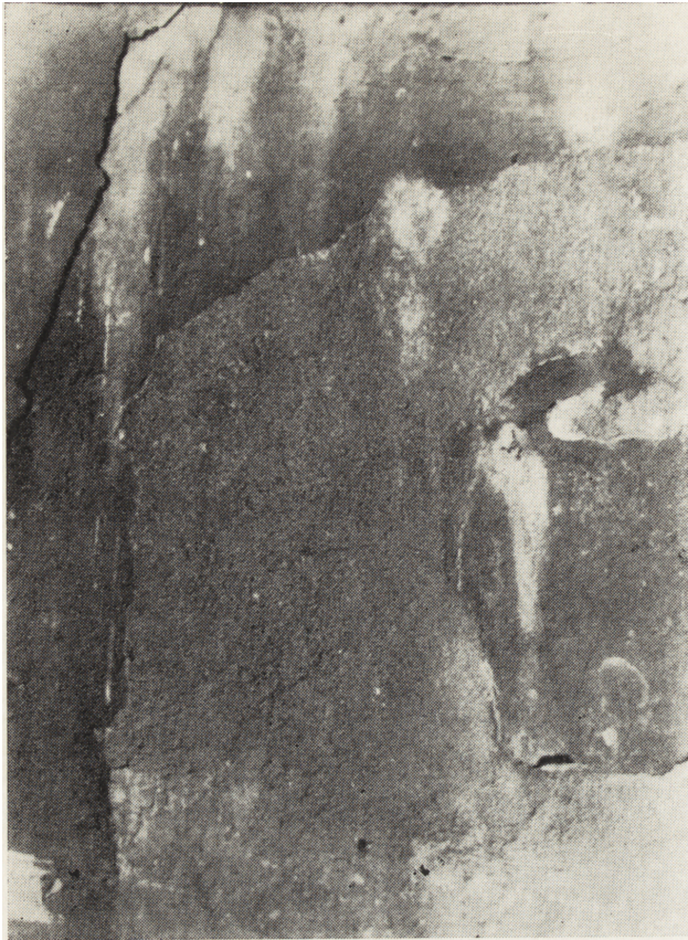
2. Trzebiatów, ul. Zajazdowa, sgraffito, stare kity wapienno-piaskowe i cementowe — pozostałość dwóch poprzednich konserwacji
