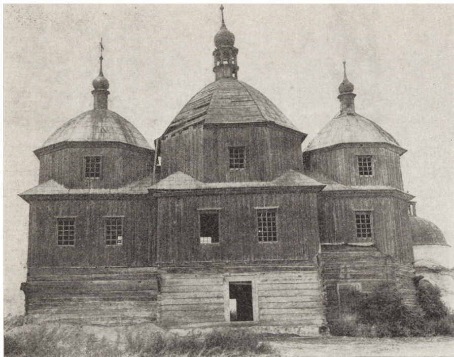
7. Wierzbica, pow. Tomaszów Lubelski, dawna cerkiew prawosławna pw. św. Michała Archanioła z r. 1887, widok od pd. (fot. W. Górski, 1970)
