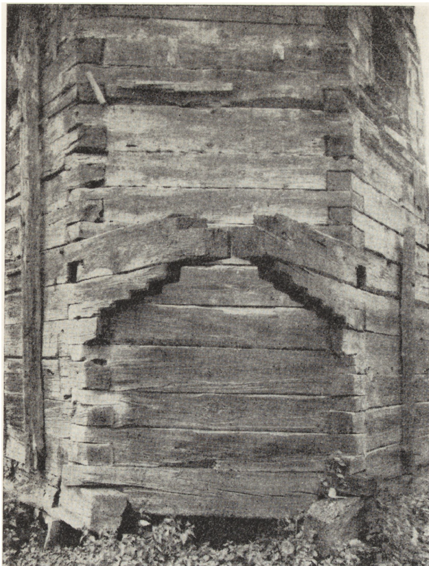
4. Korczmin, pow. Tomaszów Lubelski, dawna cerkiew gr.-kat. pw. Trzech Króli, fragment konstrukcji zrębu prezbiterium (fot. J. Langda, 1971)
