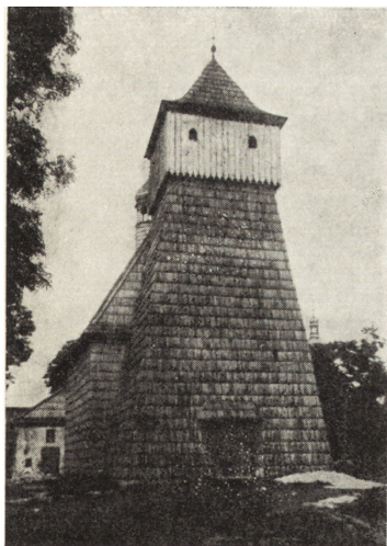
3. Ostropa pow. Gliwice. Kościół fil. p. w. św. Jerzego z 1640 r. Odbudowany w latach 1971—73, po zniszczeniach spowodowanych szkodami górnymi (fot. A. Kudła 1973)
