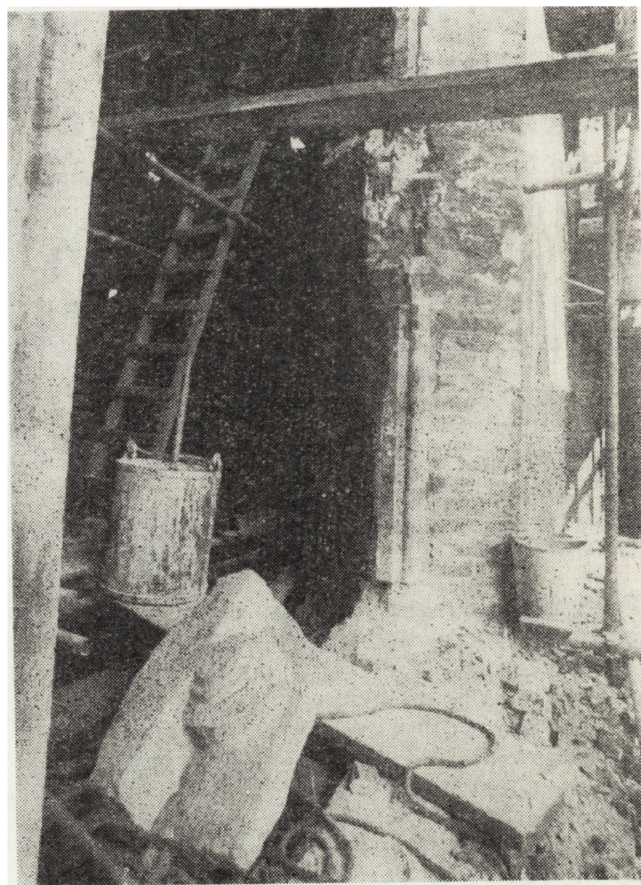
19. Wrocław, katedra. Widok ościeży okna i bazy laski środkowej w toku robót (Fot. autor)
