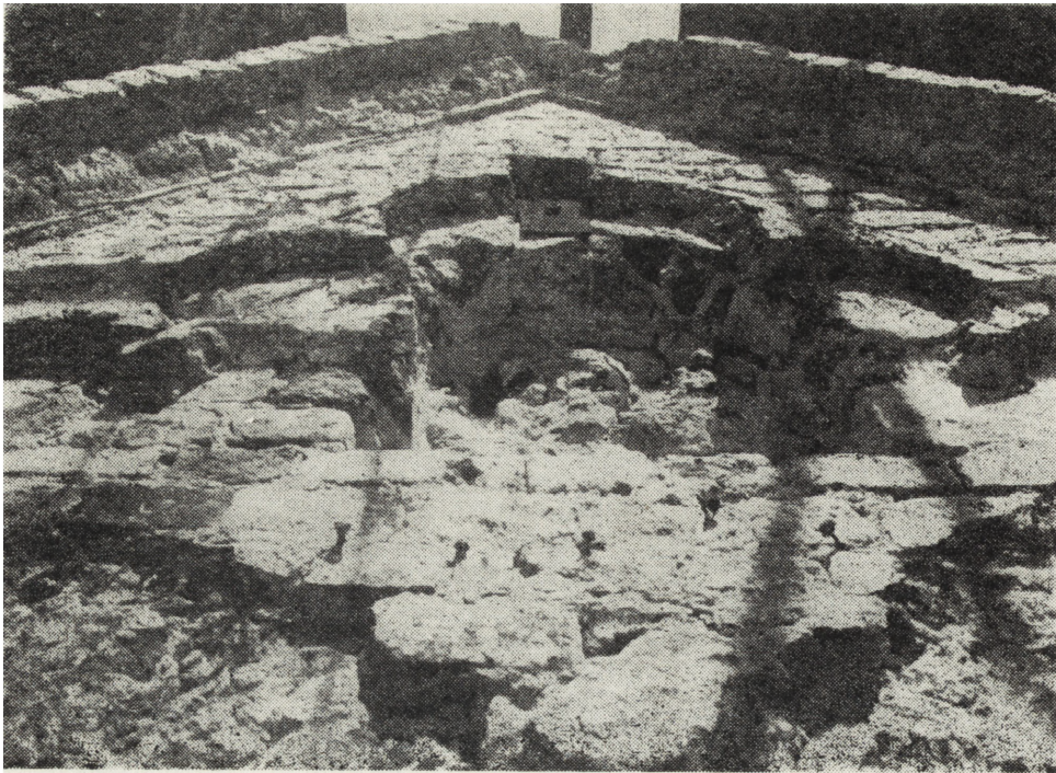
7. Wrocław, katedra. Widok wierzchołka szczytu w toku badań po odsłonięciu przemurowań (Fot. A. Hawalej)
