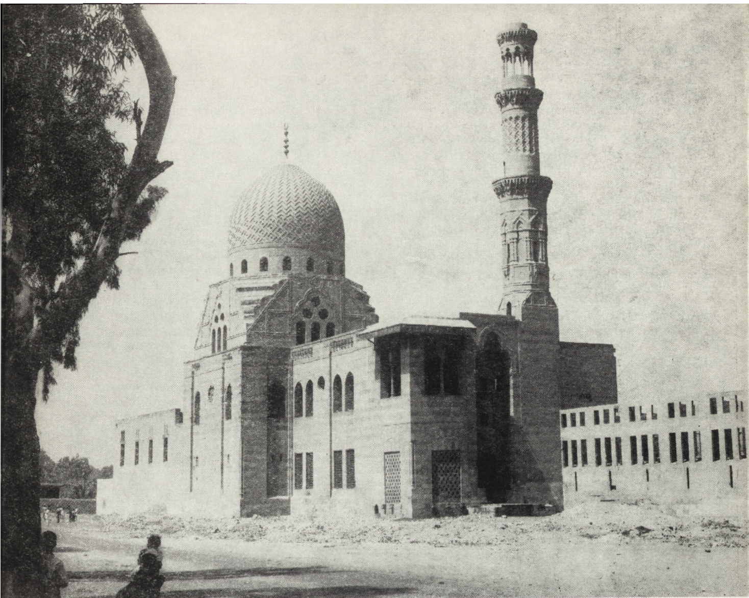
1. Kair, kompleks „Emir Kurkumas” — widok ogólny, od prawej: „chanka”, meczet mauzoleum, rezydencja 1. Cairo, architectural complex of „Ameer Qurqumas”: general view; right to left — the „khanka”, the mosque, the mausoleum and the residence (photograph W. Jerke, 1972)
