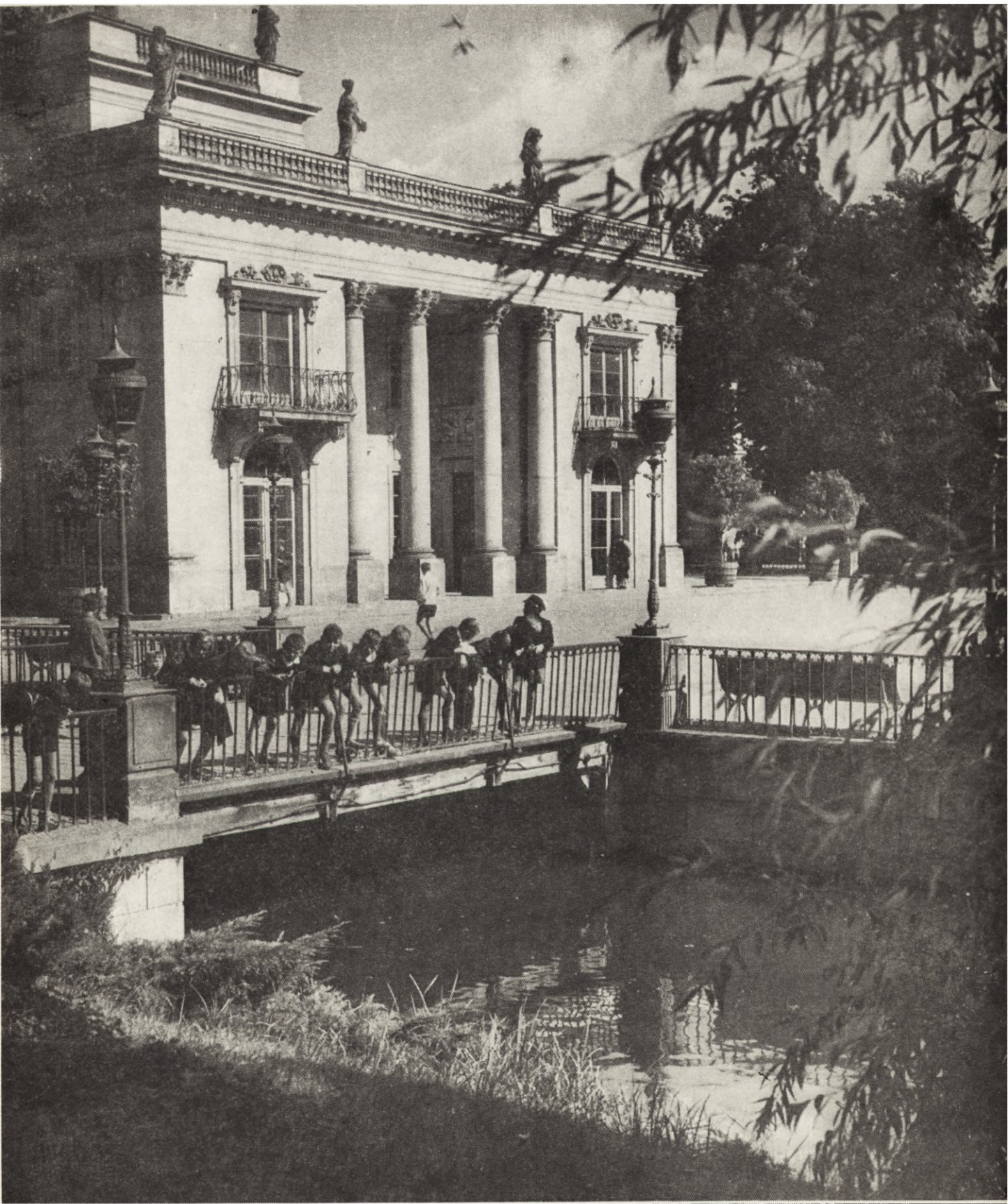
Zabytki polskie — pałac „Na wodzie” w warszawskich Łazienkach (1683—1690 i 1775—1795) (fot. K. Nowiński) Polish Historical Monuments — The Palace called „On Water” sited in Warsaw’s Łazienki Park, its in initial architectural forms erected in 1683—1690 and replaced by a totally new building in 1775—1795
