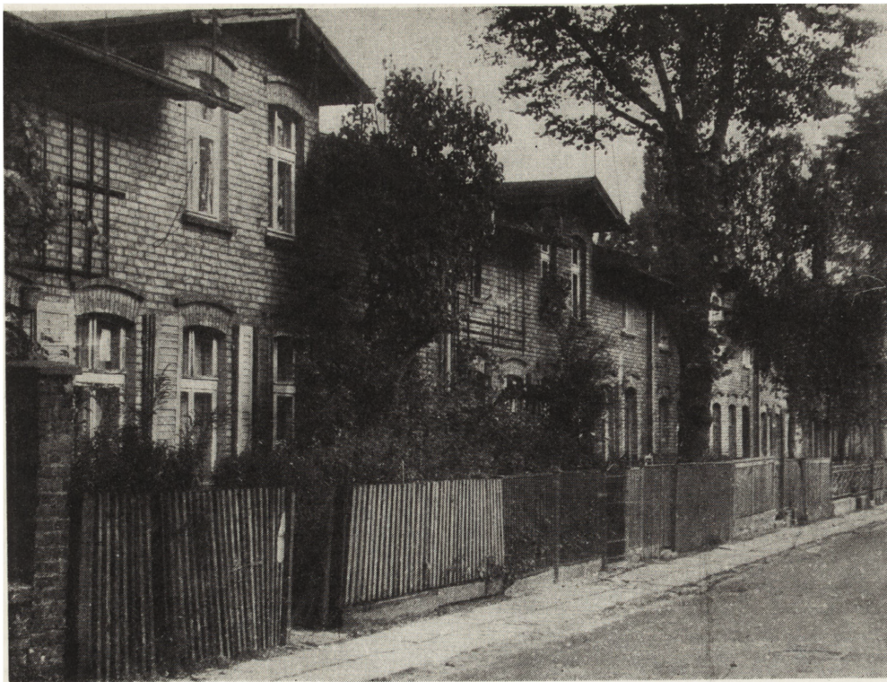
8. Gdańsk - Wrzeszcz, ul. Własna Strzecha. Fundacyjne osiedle szeregowych domków robotniczych z drugiej połowy XIX w. stanowi problem z zakresu historii, urbanistyki, architektury, a także krajobrazu.
