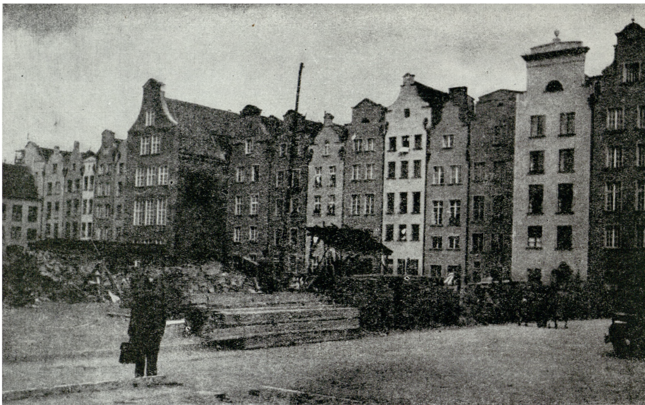
6. Gdańsk, odbudowa kamienic przy ul. Długiej (fot. L. Jabrzemski)
