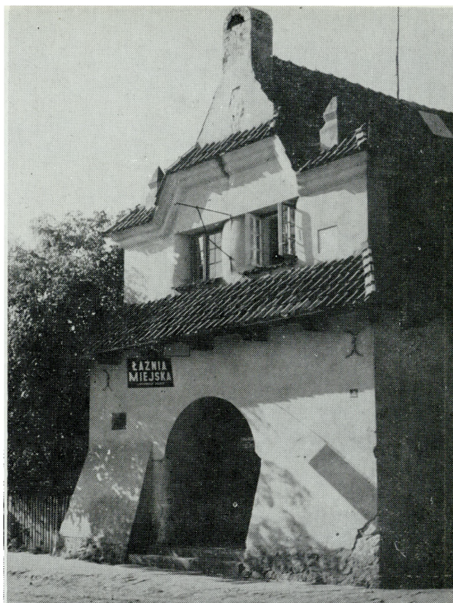
15. Kazimierz Dolny, ul. Senatorska, budynek Łaźni Miejskiej, proj. J. Koszczyc-Witkiewicz (fot. K. Popiołek)
