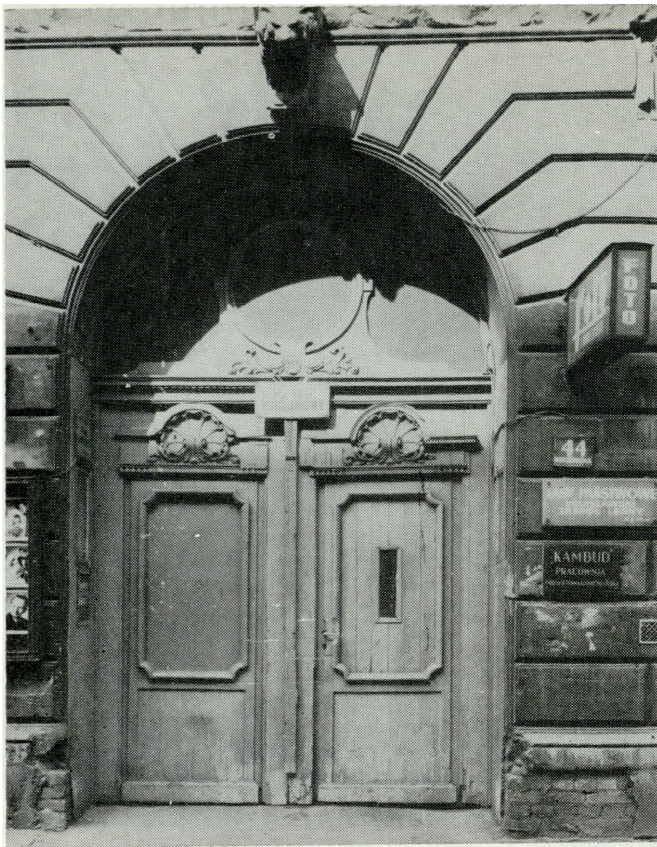
3. Warszawa, ul. Nowogrodzka 44, brama kamienicy, eklektyczna, o cechach klasycyzującego renesansu z zachowanymi drewnianymi rzeźbionymi wrotami (fot. J. Szandomirski)
