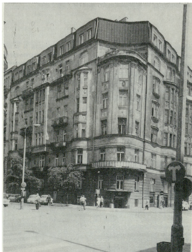
2. Warszawa, ul. Nowogrodzka 40, kamienica o cechach modernizmu klasycyzującego (fot. K. Kowalska)
