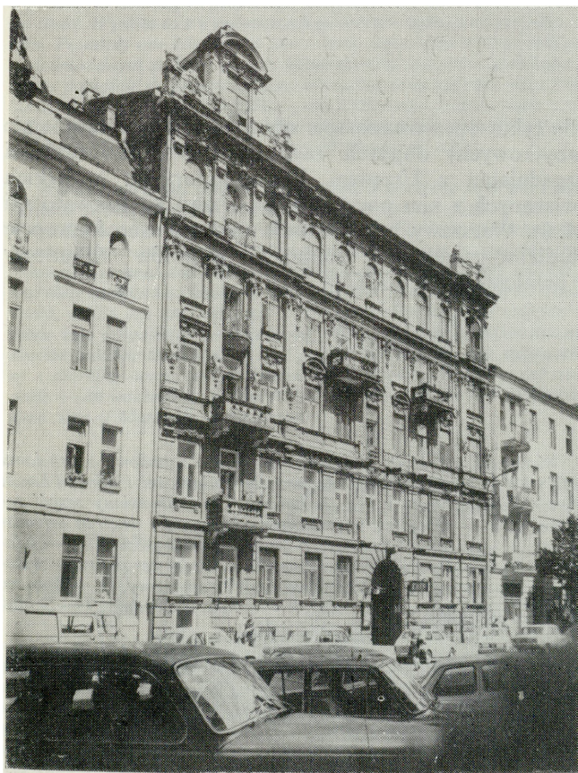
1. Warszawa, ul. Nowogrodzka 44, kamienica eklektyczna (fot. A. Juszcak)
