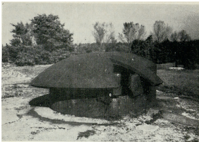
5. Modlin, wieżyczka pancerna opuszczonego fortu VII, gruntownie przebudowanego w latach 1912—1914
