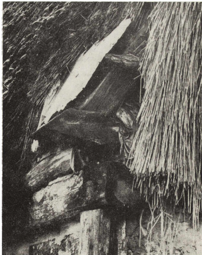
6. Dach o konstrukcji krokwiowo-balkowej (fot. St. Machala)
