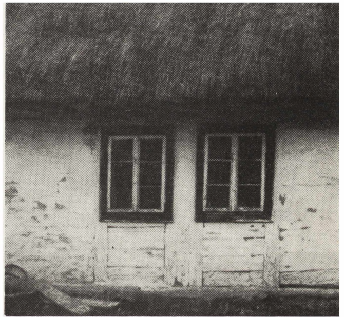
2. Otwory okienne osadzone w łatkach (fot. St. Stępień) 2. Window openings set in special framing
