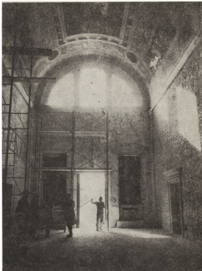
16. Bagnolo, Villa Pisani, sala główna, widok na ścianę frontową po odmurowaniu okna termalnego (fot. C. Matteucci)
