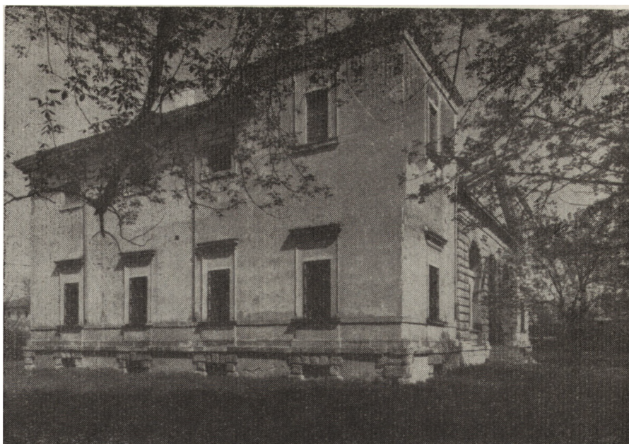
7. Bagnolo, Villa Pisani, elewacja boczna przed rozpoczęciem prac konserwatorskich 7. Bagnolo, Villa Pisani, side elevation before commencing conservation works
