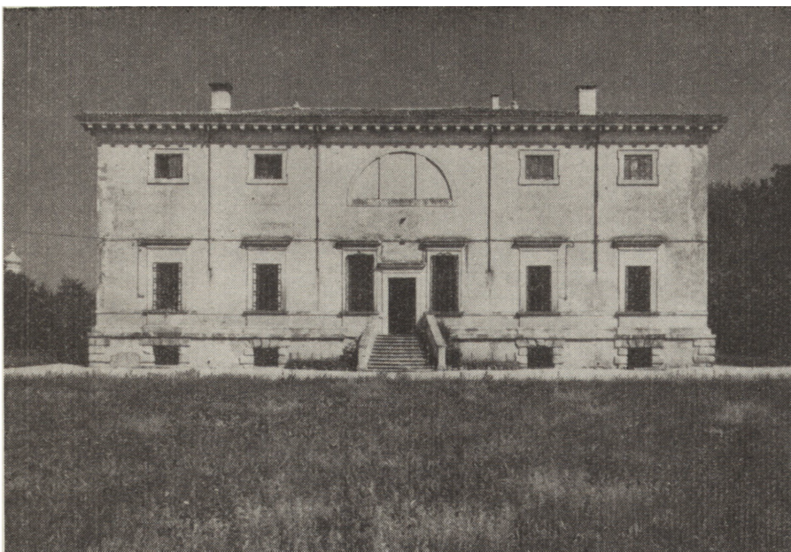
5. Bagnolo, Villa Pisani, elewacja frontowa przed rozpoczęciem prac konserwatorskich 5. Bagnolo, Villa Pisani, front elevation before commencing conservation works
