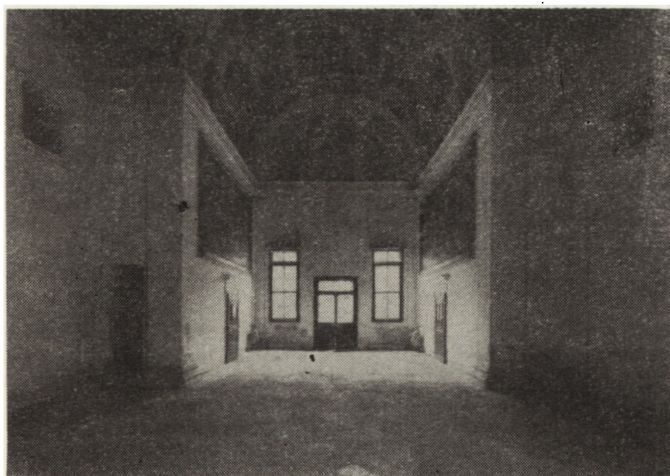
15. Bagnolo, Villa Pisani, sala główna, widok na ścianę frontową z zamurowanym oknem termalnym (przed rozpoczęciem prac konserwatorskich)
