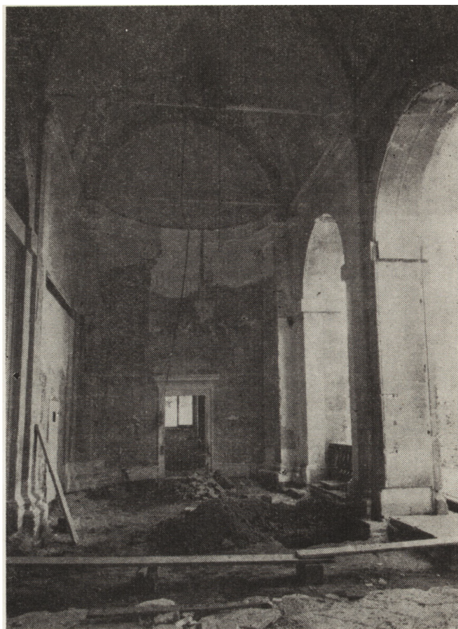
11. Bagnolo, Villa Pisani, wnętrze loggii po usunięciu dzielących ją ścianek (fot. C. Matteucci)
