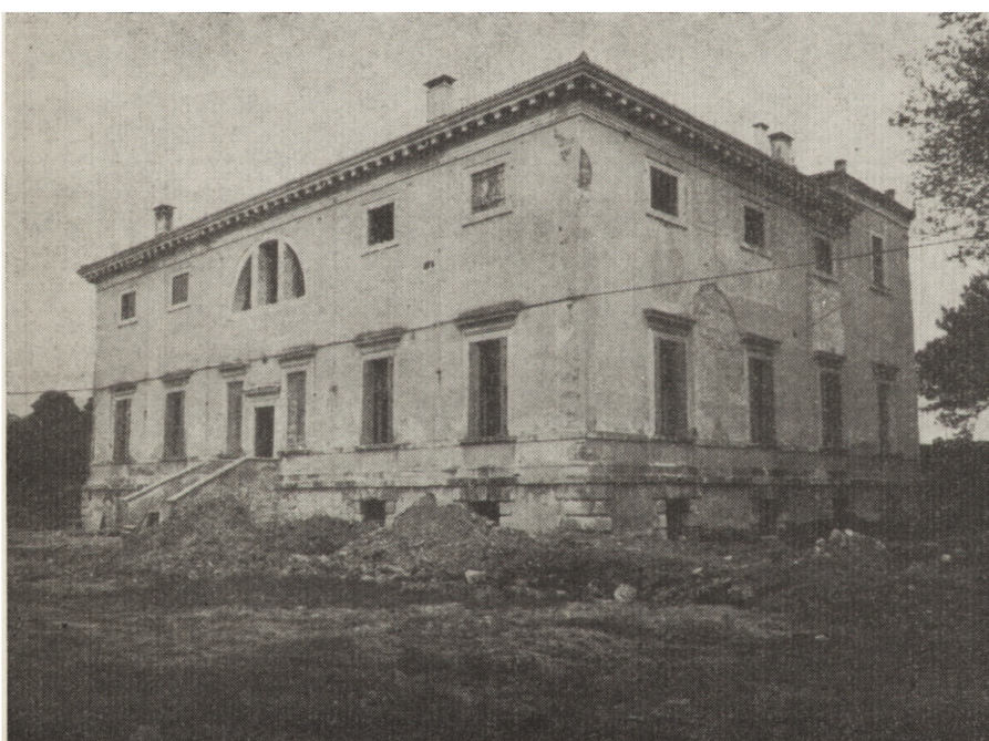
6. Bagnolo, Villa Pisani, elewacja frontowa w czasie prac konserwatorskich po przywróceniu otworom dawnych wymiarów (fot. C. Matteucci)
