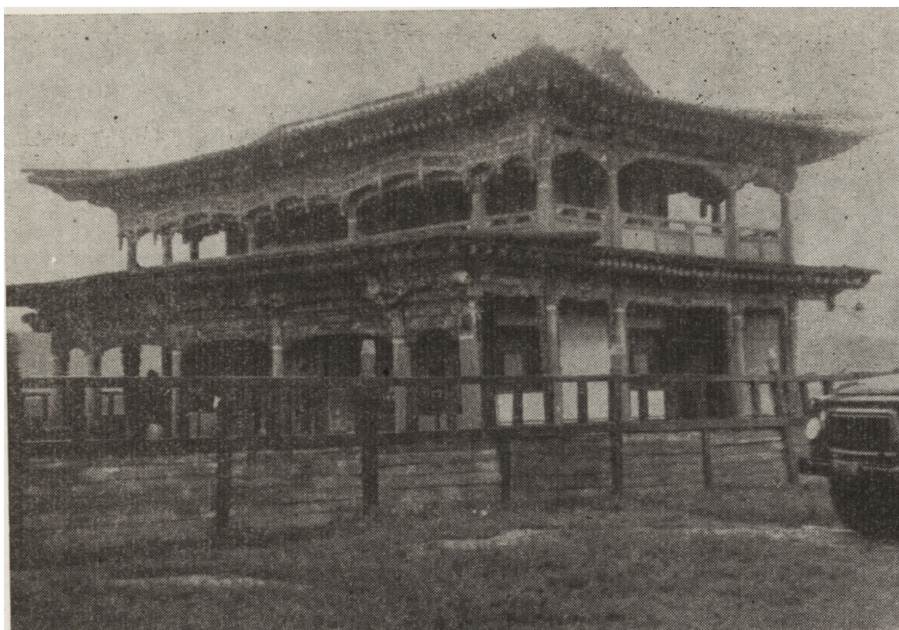
2. Świątynia w Erdeni-Cogt 2. Temple at Erdeni-Cogt
