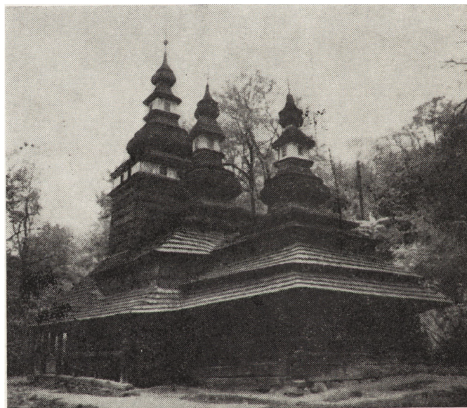
7. Medvedovce na Rusi Zakarpackiej (od 1929 r. w Pradze), dawna cerkiew greckokatolicka, XVIII w.; na gzymsach i szalunku deskowym widoczne resztki dawnego malowania, zwłaszcza bieli (fot. R. Brykowski, 1976 r.)
